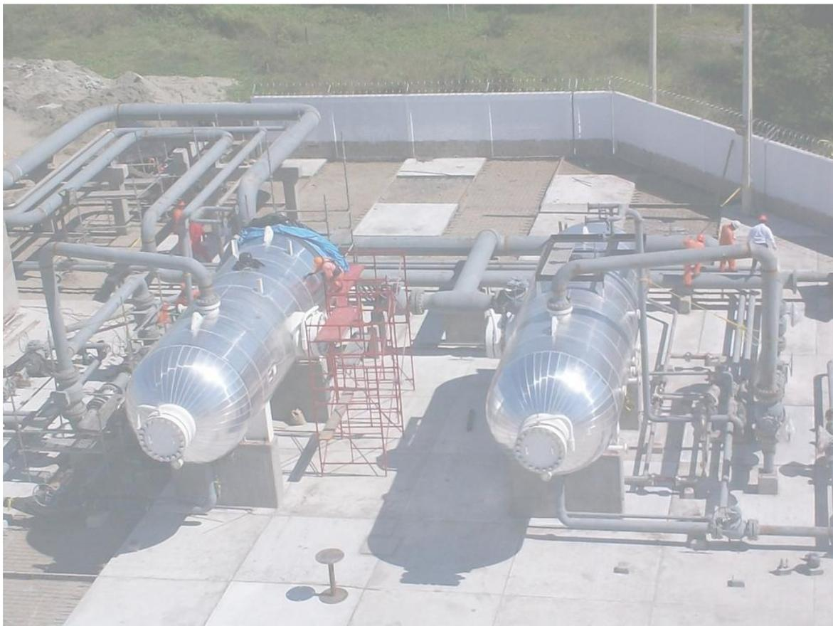
*Ilustración 32.- Separadores Ciclónicos Utilizados en la Industria Petrolera.*
