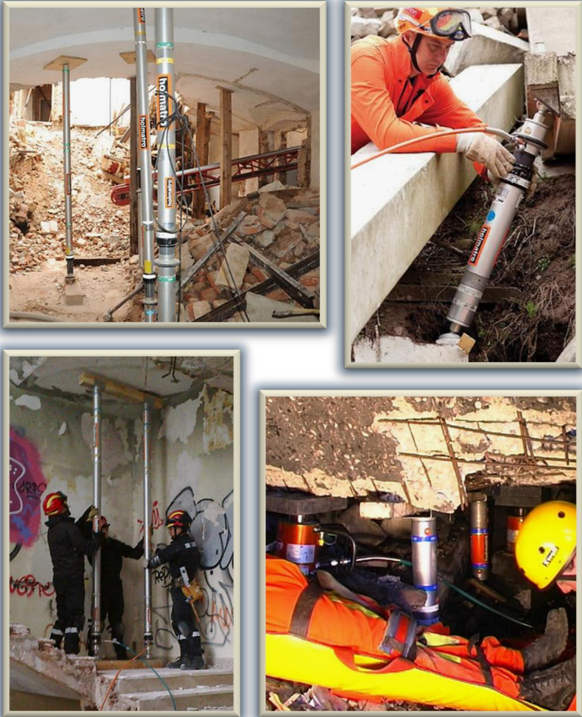
Fig. 2.1.2.25 Imágenes de usos de puntales neumáticos e hidráulicos. Arriba izq., soportes neumáticos apuntalando edificio parcialmente colapsado. Abajo izq., puntales hidráulicos para soporte de losa en descanso de escalera. Arriba y abajo der., soportes hidráulicos de corta longitud con capacidad de elevación remota, utilizados sobre todo para operaciones de rescate en espacios reducidos
