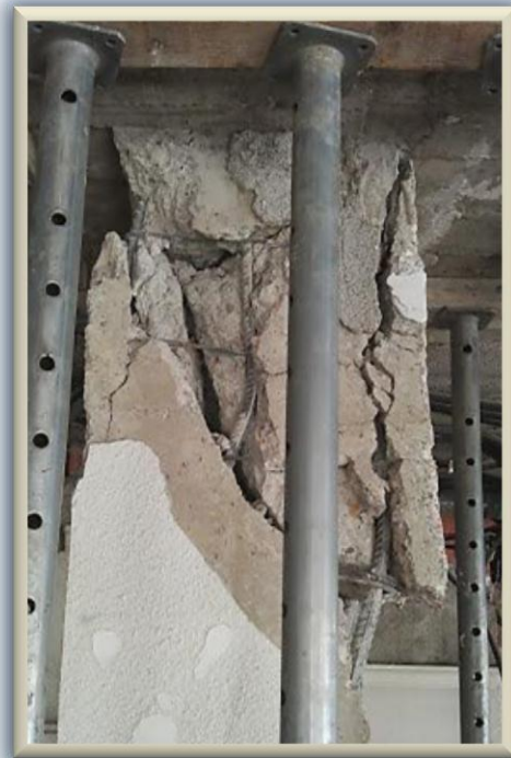
Fig. 2.1.2.19 Apuntalamiento de emergencia rápido y eficaz, alrededor de columna colapsada. Mismo edificio de las figs. 2.1.2.13.a y 2.1.2.13.b
