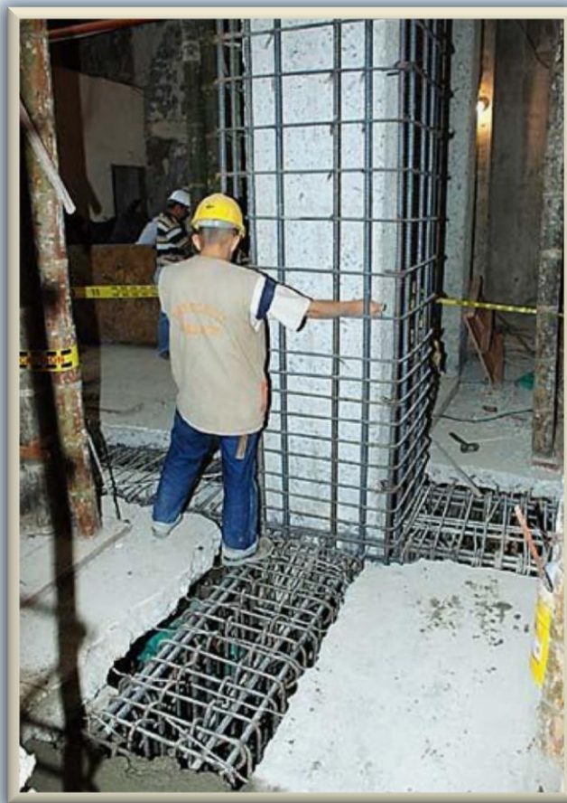
Fig. 2.4.3.3. Armados de nodos viga-columna. Arriba, imagen y esquema de anclaje y disposición de estribos acorde con la reglamentación actual. Abajo, armado para encamisado integral nodo-viga-columna
