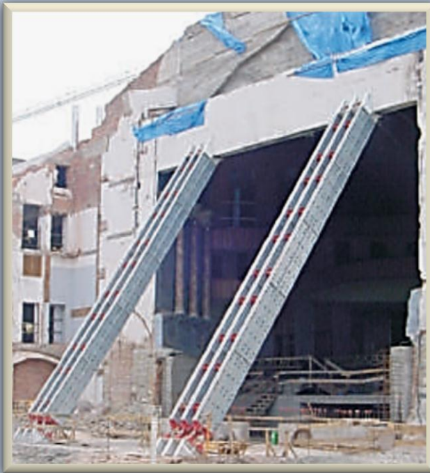
Fig. 2.1.3.7. Apuntalamientos a base de perfiles estructurales especiales. Arriba, entibado de muros de cimentación mediante puntales individuales de gran longitud y resistencia. Abajo izq., misma clase de puntales pero dispuestos en bloques, reteniendo un pesado pórtico de concreto. Abajo der., acercamiento de bases y accesorios de conexión
