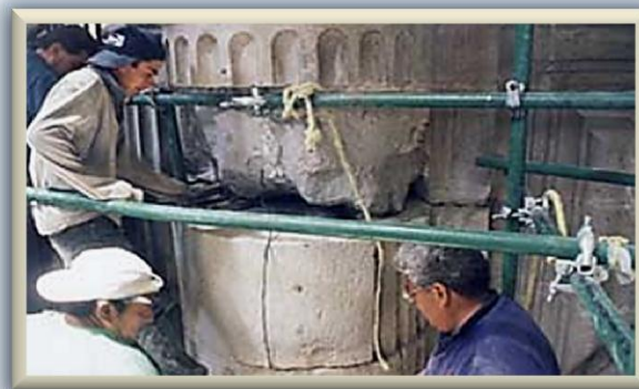
Fig. II.19. Sustitución de sillares en la columna C-6
