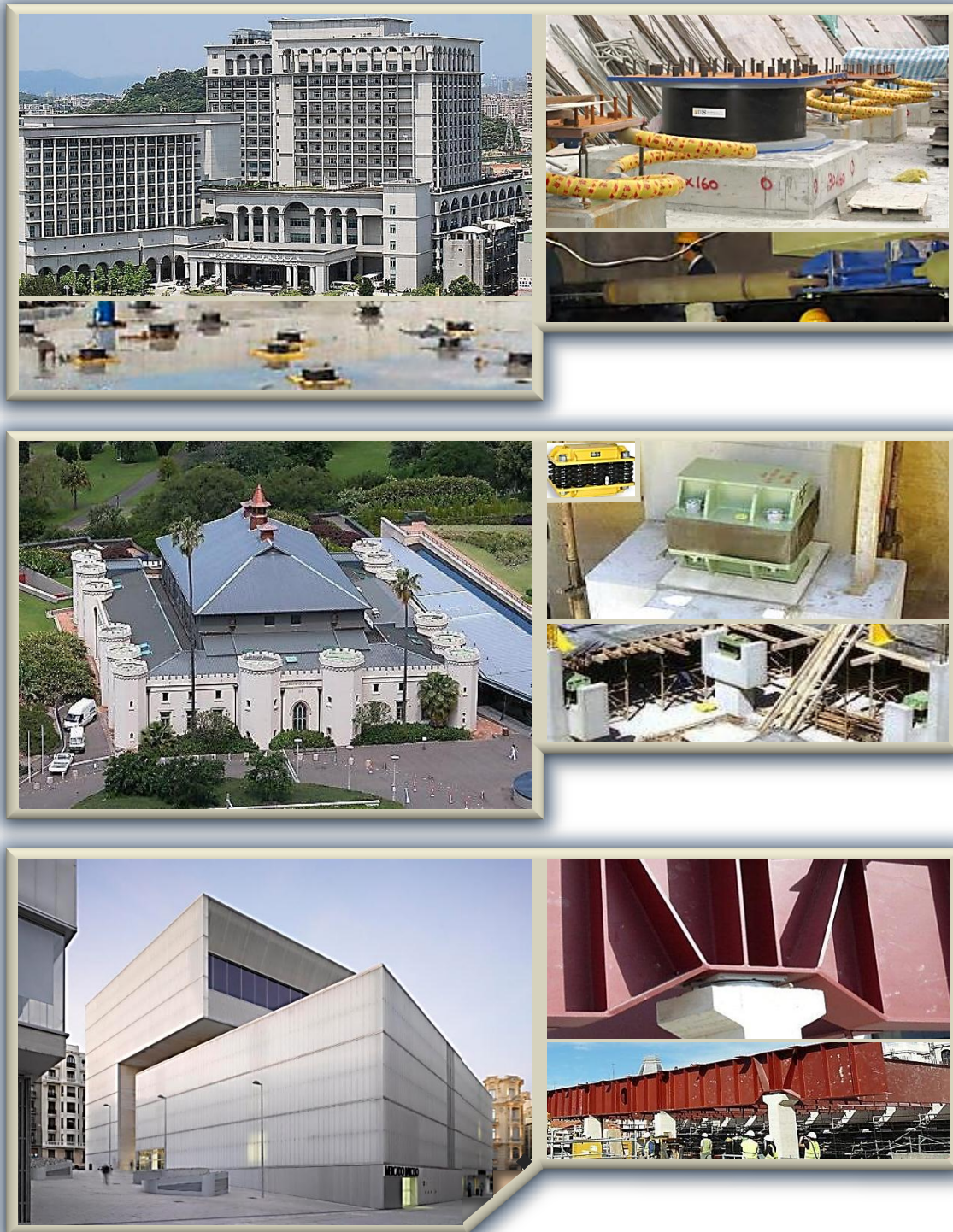
Fig. 3.3.10. Uso extensivo alrededor del mundo de múltiples dispositivos de aislamiento basal. Arriba, aisladores LRB's, RB's y SB's, mas amortiguadores viscosos y de acero tipo muelle, suman 349 elementos que conforman el 2° mayor sistema de aislamiento del orbe, para un centro hospitalario, el "Tzu-Chi" de Taipei, Taiwán. En medio, aisladores de resortes pretensados, en el "Conservatorium of Music" de Sidney, Australia. Abajo, apoyos deslizantes guiados tipo Pot, sustentando un gran volumen prismático del Polideportivo del "Centro Barceló", en Madrid, España
