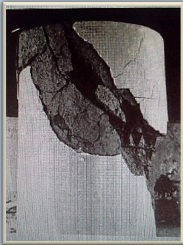
Fig. 1.2.1.a.1-3) Más ejemplos de fallas típicas por cortante en columnas de concreto reforzado
