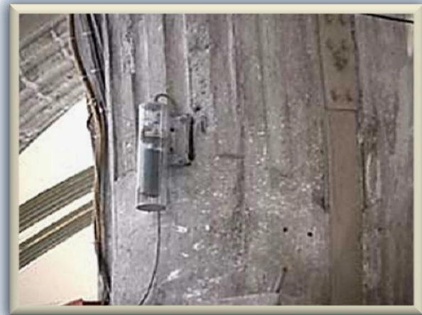
Extensómetro en el arranque del arco sur bajo la cúpula del Sagrario
