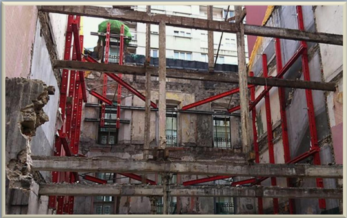
Fig. 2.1.2.15 Apuntalamientos “estabilizadores” a base de perfiles metálicos con arriostramientos horizontales coplanarios y oblicuos, que cuando se colocan interiormente, como en estos ejemplos, al diseñarlos debe preverse que no interfieran con los trabajos de rehabilitación
