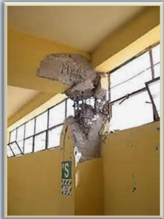
Fig. 1.2.1.a.1-2) Otras demostraciones de fallas por tensión diagonal (cortante) que siempre provocan grietas diagonales, no obstante existan elementos adicionales de contención o restricción de cargas laterales
