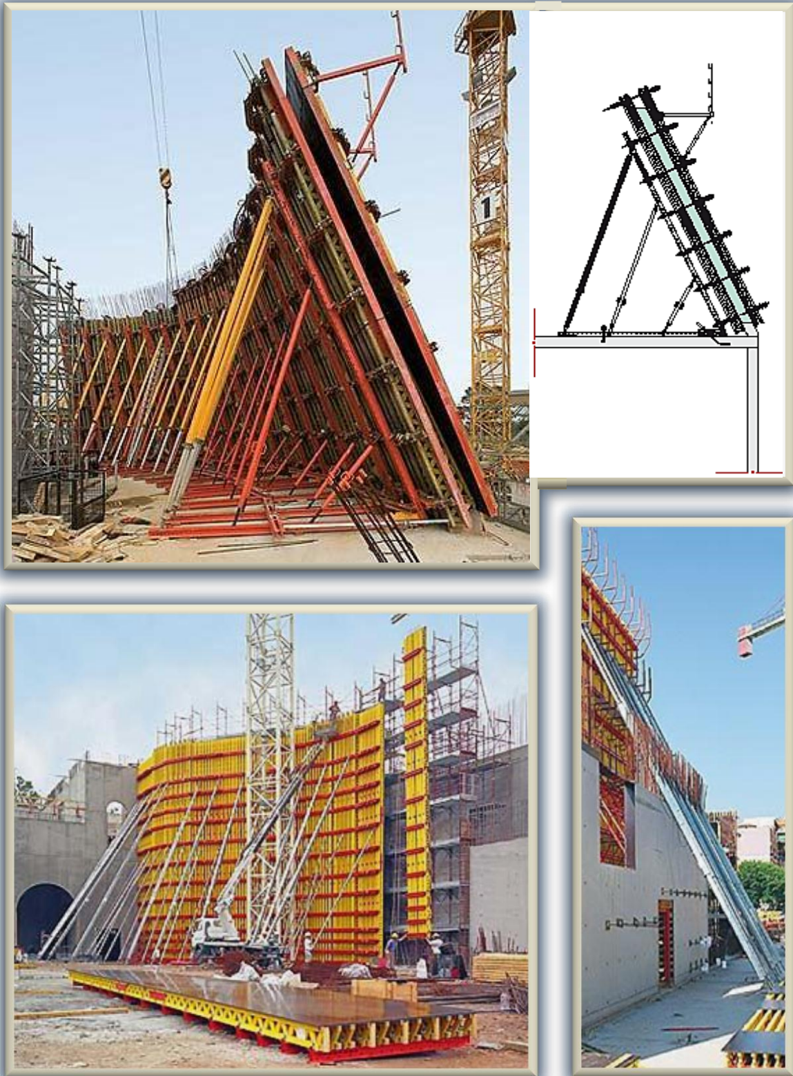
Fig. 2.1.3.6. Apuntalamientos oblicuos con puntales metálicos de gran capacidad de carga. Arriba, sistema triangular de 3 puntales paralelos soportando cimbra inclinada. Abajo, puntales telescópicos de acero alcanzando 14 m. de altura
