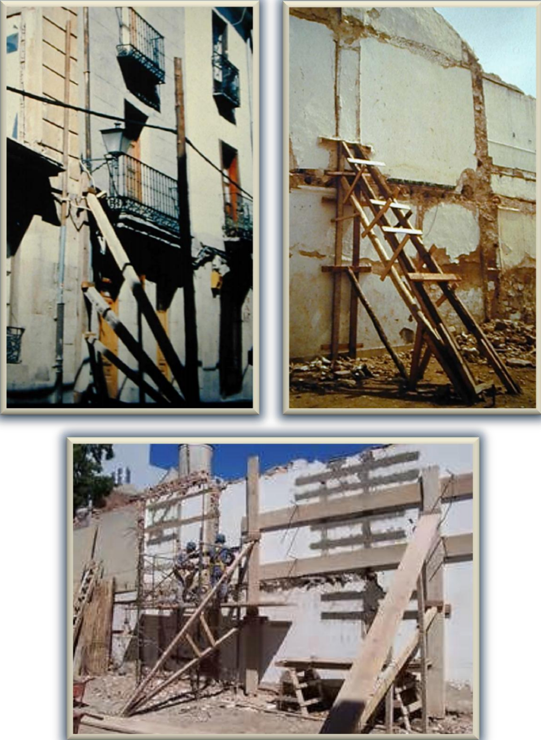
Fig. 2.1.3.3. Apuntalamientos inclinados de madera. Arriba izq., 3 puntales en abanico dando soporte a una fachada. Arriba der., muro de doble altura sostenido con puntales paralelos. Abajo, barda de más de 5 m. de altura apuntalada en secciones equidistantes de 2 tablones en abanico
