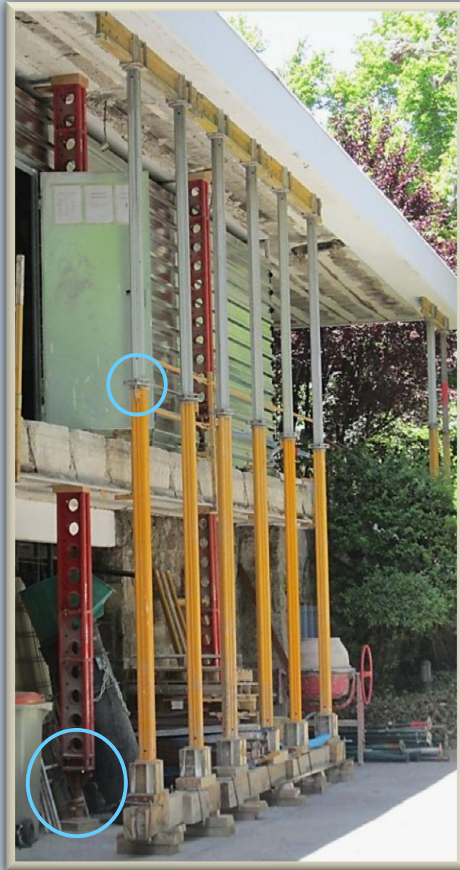
Fig. 2.1.2.21 Puntales telescópicos de mayor capacidad de carga y altura que los tubulares convencionales. Los amarillos son de aluminio, muy ligeros, con peso de 19 kg. y capacidad portante de 90 kN, así como una longitud máxima extensible de 6.25 m. Los de color rojo son de muy elevada capacidad de carga, la cual se encuentra en el rango de los 180 a 200 kN, también son
