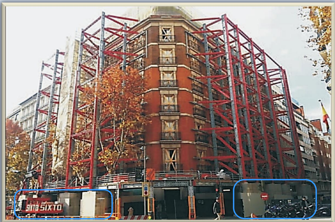
Fig. 2.1.3.8. Sistemas de soporte lateral denominados “estabilizadores”, contruidos con perfiles de acero. Arriba, estabilizadores y esquema con datos de cálculo, de una fachada de más de 10 m. de altura. Abajo, edificio de 7 niveles con estabilizadores asentados en basamentos de concreto (contrapesos)
