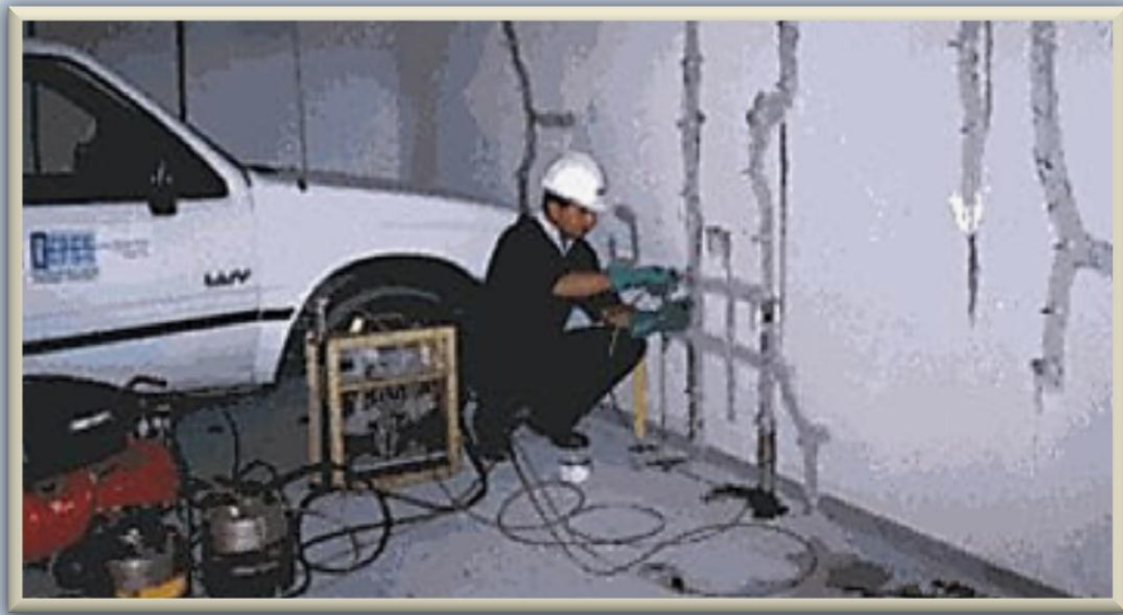
Fig. 2.3.1.4. Tapado de grietas con equipo de inyección de despl. positivo y presión máx. de 500 psi. La correcta aplicación garantiza el monolitismo estructural
