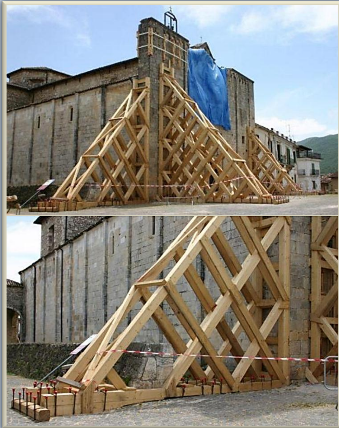
Fig. 2.1.3.4. Apuntalamientos de triángulo completo de fachada de mampostería, constituidos por 2 hileras de 3 puntales inclinados paralelos, con riostras de apoyo y cruzadas. Abajo, acercamiento para apreciar el anclaje de la base
