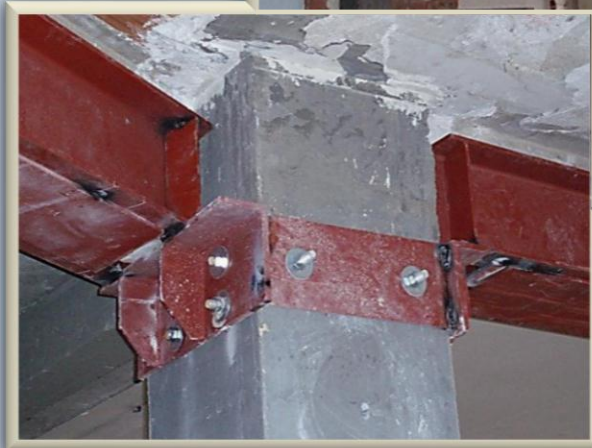
Fig. 2.4.2.5. Encamisados metálicos para vigas. Arr., el tipo más común, placa con conectores atornillados reforzando trabe fracturada; der., esquemas de variantes. Abj., encamisado completo con perfiles; nótese collarines de apoyo en columnas
