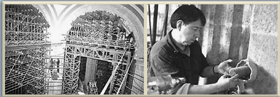
Fig. II.14. Extracción de corazones de columnas de la Catedral y el Sagrario
