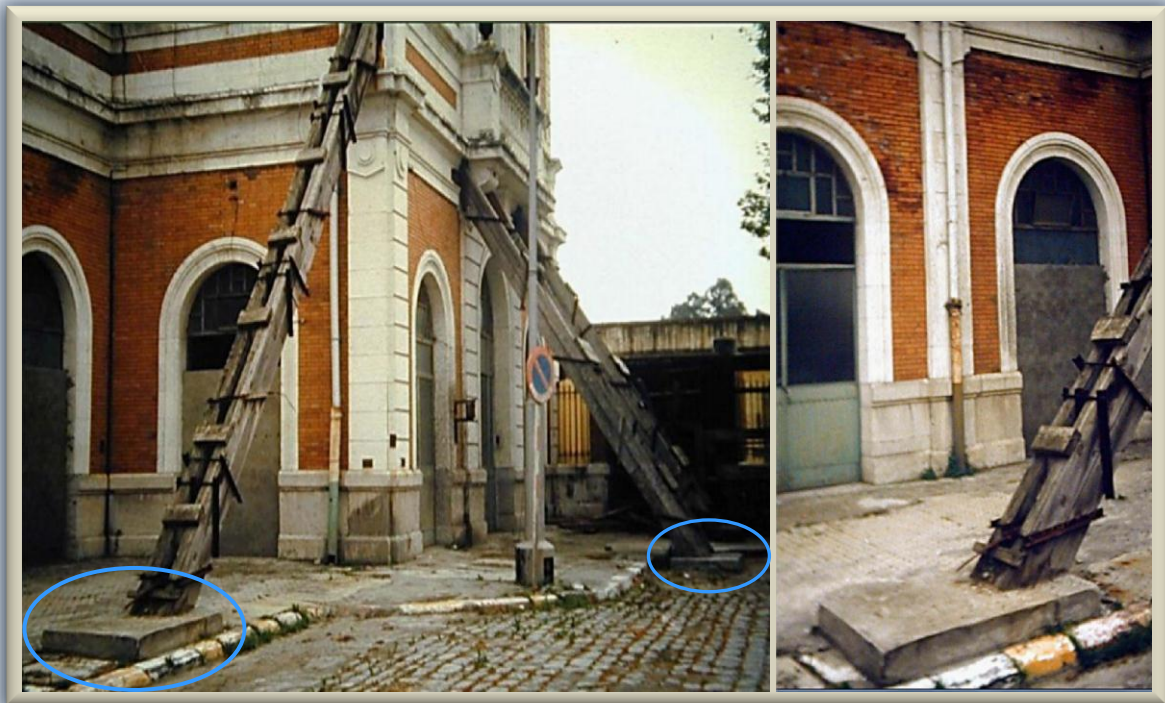
Fig. 2.1.3.5. Apuntalamientos constituidos por elementos de grandes dimensiones. Arriba, 2 líneas de puntales en paralelo dando soporte en dos niveles de portal de mampostería. Abajo, puntales dobles largos conformados con vigas unidas con bridas de acero y tablillas. En ambos, nótese dado de concreto que se forja para empotrar la base de los puntales.
