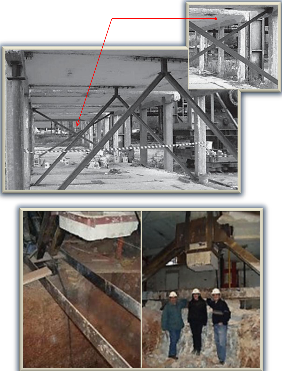
Fig. 2.1.3.20. Uso provisional de contraventeos. Arriba, de tipo excéntrico para apuntalamiento de marcos, y simple para nodos de columnas. Abajo, sistema de arriostramiento a base de perfiles estructurales para pila de cimentación
