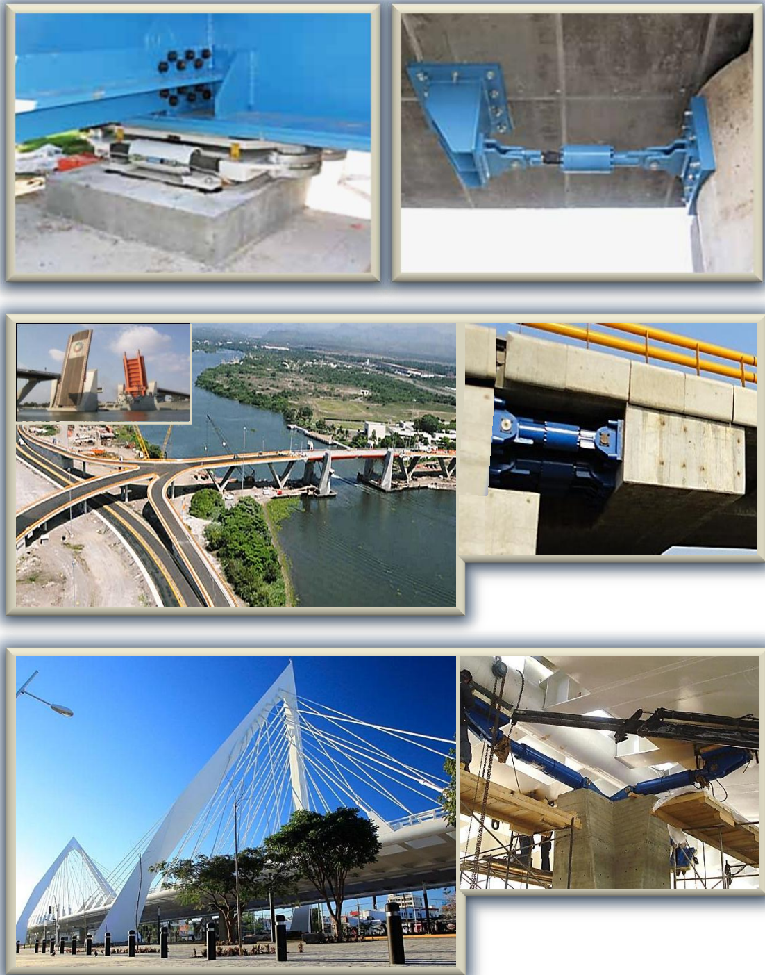
Fig. 3.3.7. Empleo de disipadores de energía en puentes y vías elevadas de México. Arriba izq., disipador histerético en apoyo plano de puente. Arriba der., amortiguador de fluido viscoso en conexión tablero-columna de un paso elevado. En medio, amortiguadores de fluido viscoso en juntas de unión tablero-columna, en tramos extremos del puente basculante “Albatros”, en el Puerto de Lázaro Cárdenas, Michoacán. Abajo, una vez más, dispositivos de tipo fluido viscoso de tamaño considerable, para el puente “Matute Remus”, en Guadalajara, Jalisco
