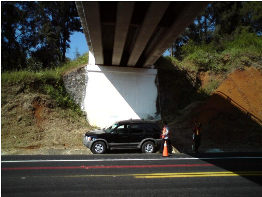
Figura 7. Fotografía del estribo no. 2.
