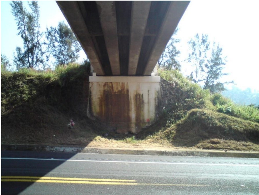
Figura 6. Fotografía del estribo no. 1.
