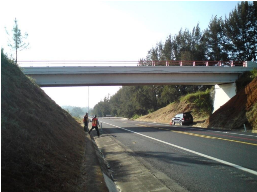
Figura 3. Fotografía de la vista general del P.I.V. en dirección a Uruapan.
