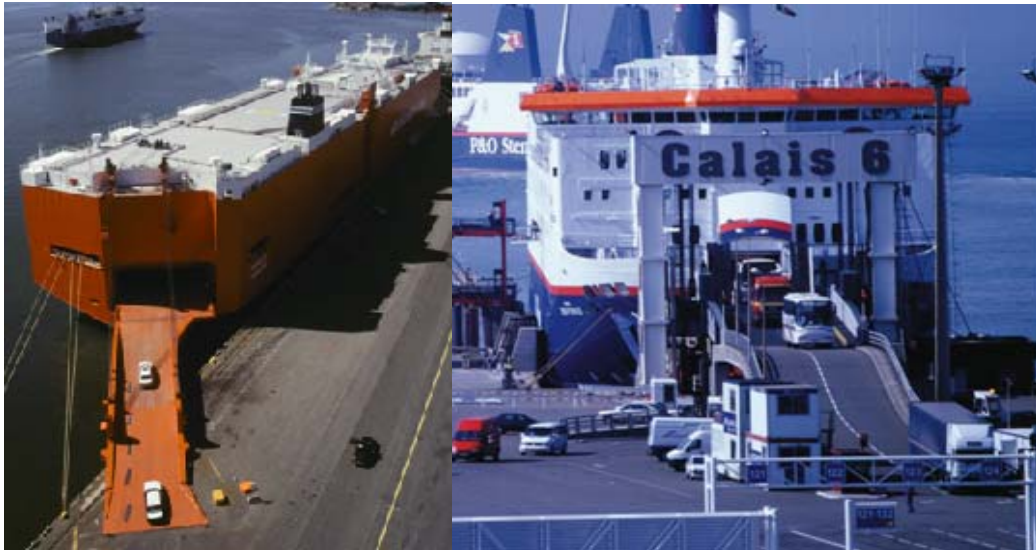
Figura 35: Ejemplo de muelles para rampas en popa de 1 y 2 niveles. Fuente Foro Iberoamericano, septiembre 2007
