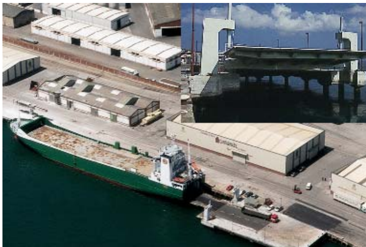
Figura 36: Ejemplo de muelle con rampa de accionamiento hidráulico. Fuente Foro Iberoamericano, septiembre 2007
