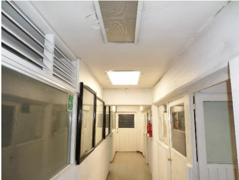
Ilustración 14, Pasillo Talleres DGOyC
