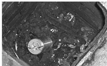
Figura 2.16 Colocación de sensor sobre vástago de válvula.
