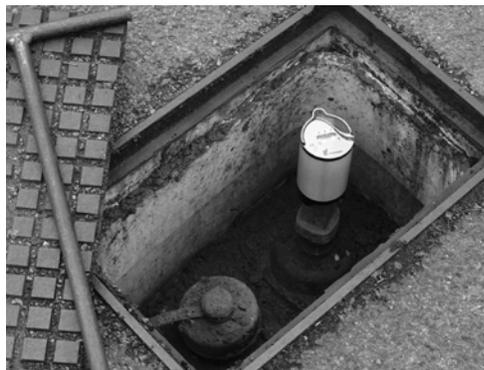
Figura 3.17 Sensor de sistema correlación sujeto mediante imán a vástago de válvula (PRIMAYER 2005).
