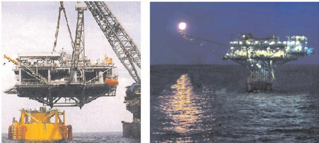
Figura 3. Plataforma Tipo Seastar, Instalación y operación. Ref. [ 2 ]
