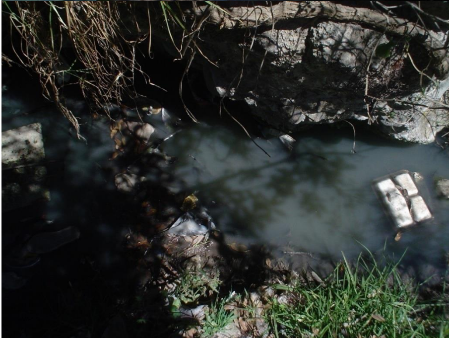
Figura vii. Zona de descarga del sistema de alcantarillado del Puerto Magú. Fotografía de Moisés González Álamo
