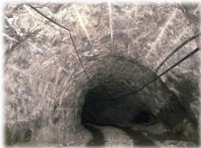
Figura 4.26 Aplicación de la técnica del abovedamiento
