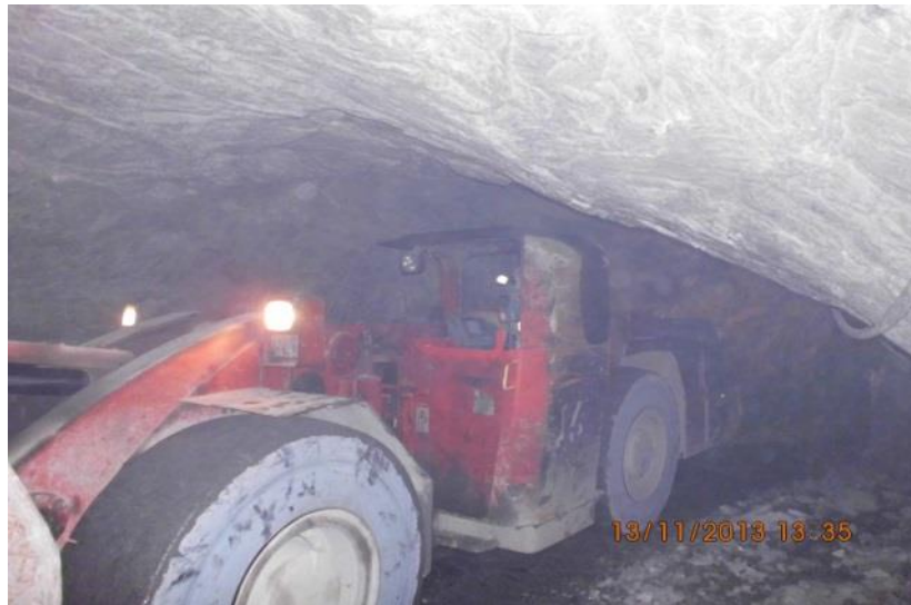
Figura 4.32 Relleno del rebaje (corte y relleno)
