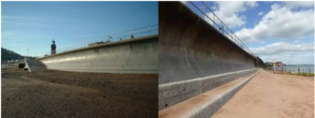
Figura 1. 10 Muro con cara frontal curva
