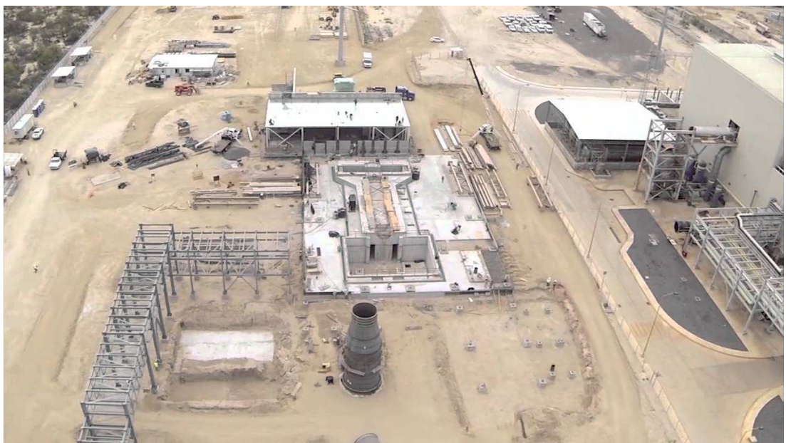
Figura 3.4. Casa de Máquinas, construcción de la cimentación
