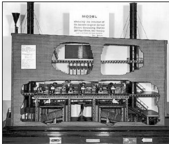
Figura 2.1. Casa de Máquinas de la Central Pearl Street Station
