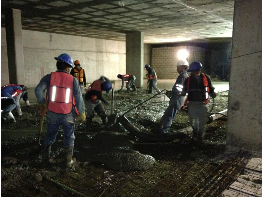
Ilustración 36. Colado de nivel N+96.40 Estacionamiento
