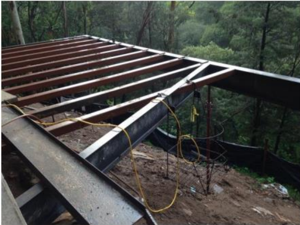
Ilustración 38. Estructura metálica para terraza cubierta de deck volada
