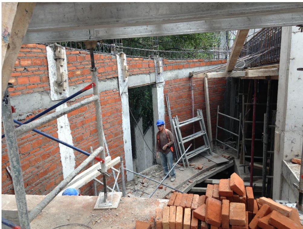
Ilustración 33. Trabajos de mampostería en rampa de Estacionamiento
