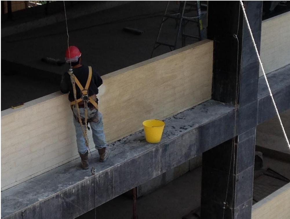
Ilustración 46. Colocación de niwalla en muretes de fachadas
