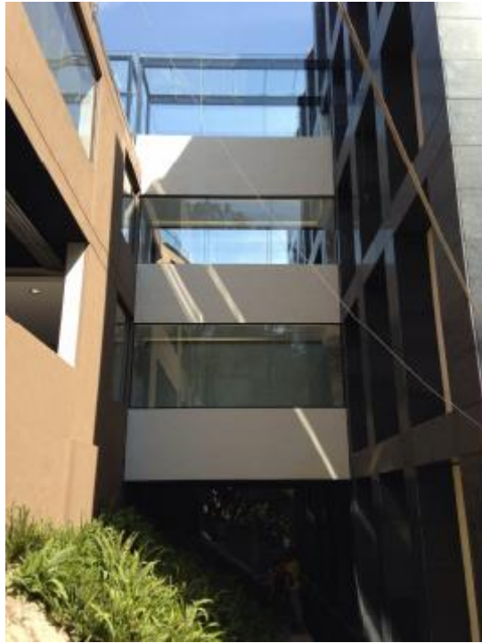
Ilustración 48. Vista de puentes con acabados y vidrios
