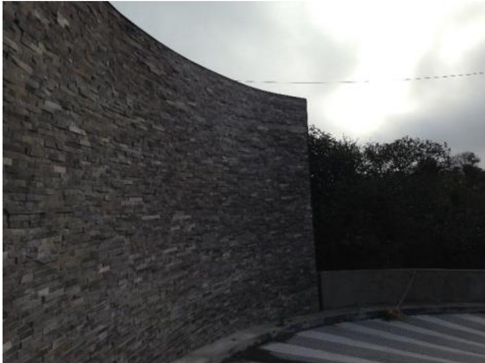
Ilustración 50. Acabado de piedra laja en bajada de estacionamiento
