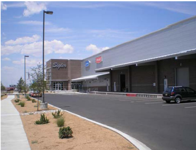
Vistas Exteriores del Edificio
