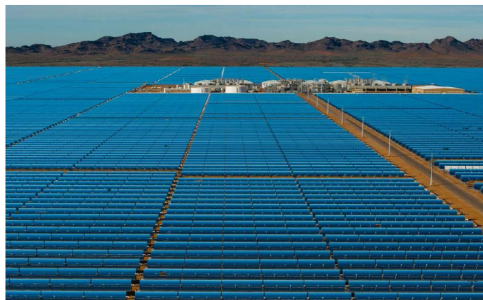
Fig. 1.9. Planta solar Solana de concentradores tipo canal parabólica con almacenamiento térmico, ocupando un área de 7.8 km 2 en el estado de Arizona, EE.UU. Instalada por Abengoa Solar.
