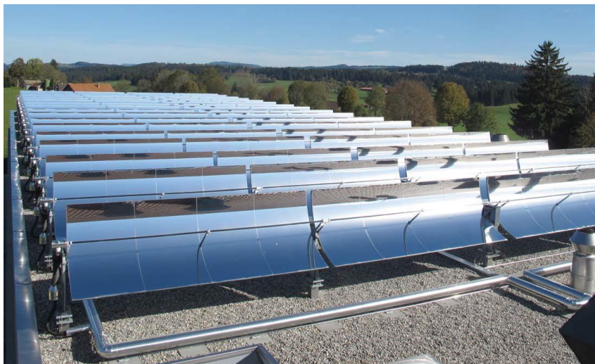
Fig. 1.5. Instalación solar Fromagerie de Saignelégier SA que abastece de energía térmica el sitio para la fabricación de la marca de quesos Tête de Moine.
