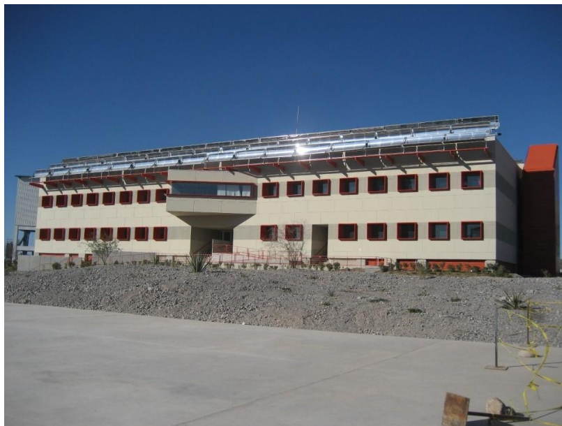
Fig. 1.6. Edificio corporativo de Cementos Apasco con sistema de concentración para aire acondicionado.
