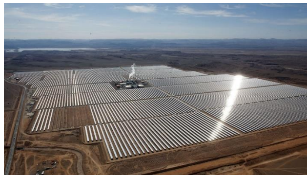
Fig. 1.10. Primera etapa del complejo solar Noor en Marruecos. 160 MW e a base de canales parabólicos con aceite térmico y capacidad de almacenamiento de tres horas
