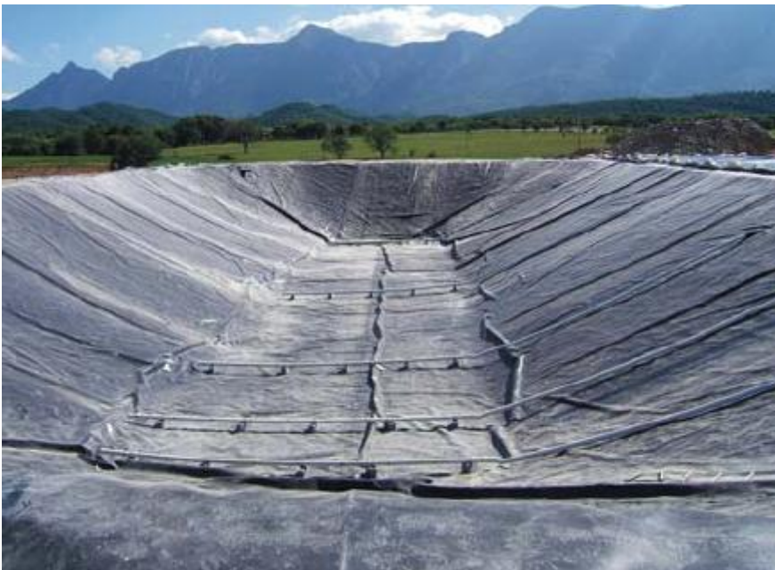
FIGURA 3.9 Construcción Biodigestor. Fase: puesta del polietileno FUENTE: Revista claridades Agropecuarias 168. Agosto 2007.
