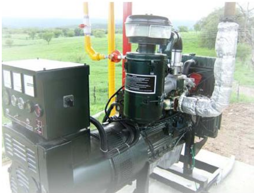
FIGURA 2.5 Motogenerador Eléctrico Alimentado Con Biogás. FUENTE: Revista Claridades Agropecuarias # 168.
