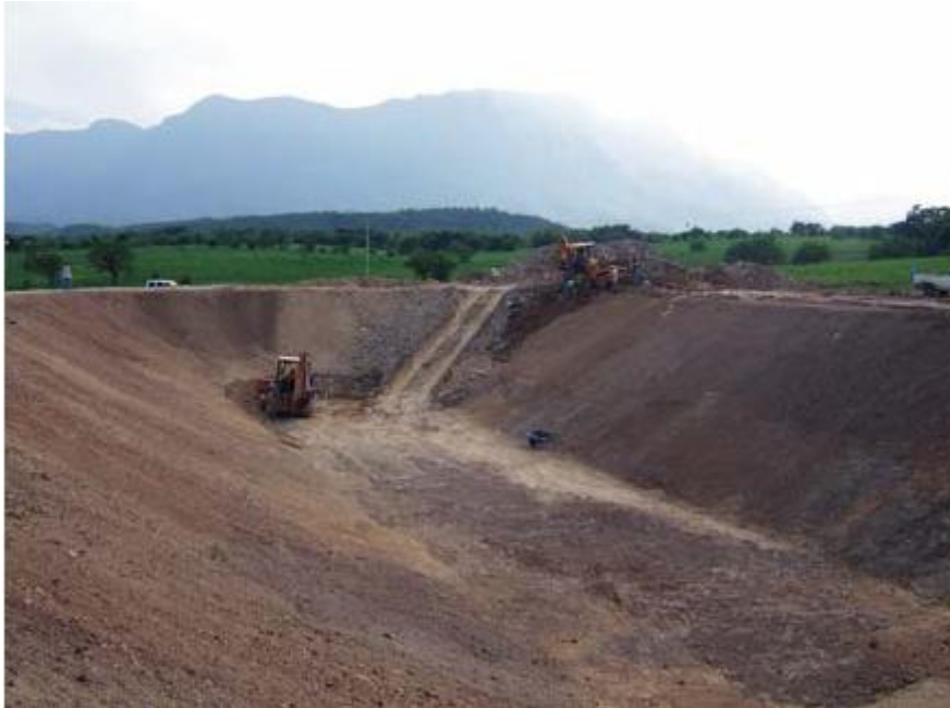
FIGURA 3.8 Construcción Biodigestor .Fase: Excavación FUENTE: Revista claridades Agropecuarias 168. Agosto 2007.
