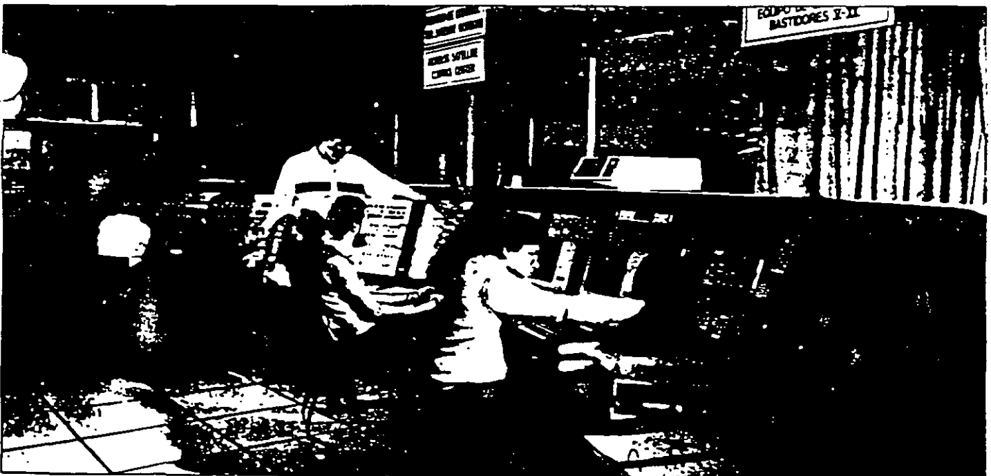
El centro de control de satélites actual, ubicado en Iztapalapa, será mejorado para manejar el sistema Solidaridad, el cual es más complejo.
