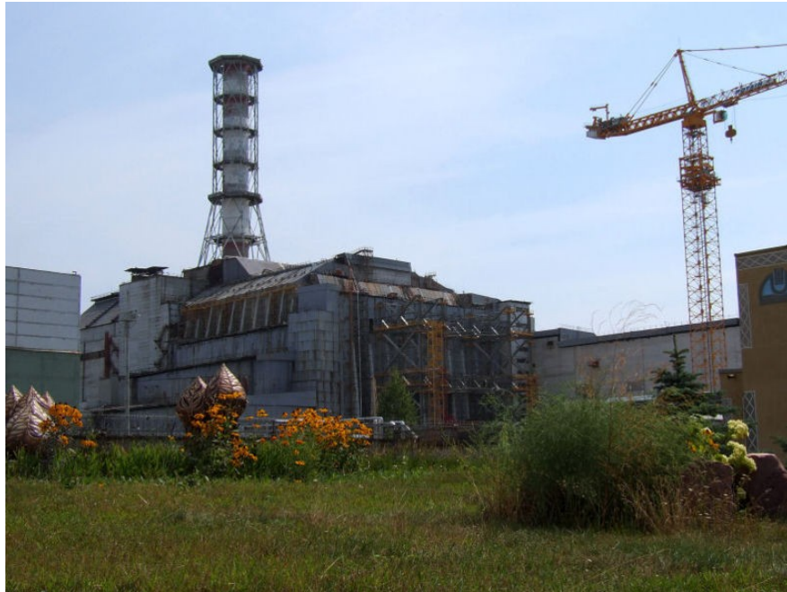
Figura 2.17 Estado actual del reactor 4 de la central de Chernobyl, con un sarcófago que impide la fuga de radiaciones
