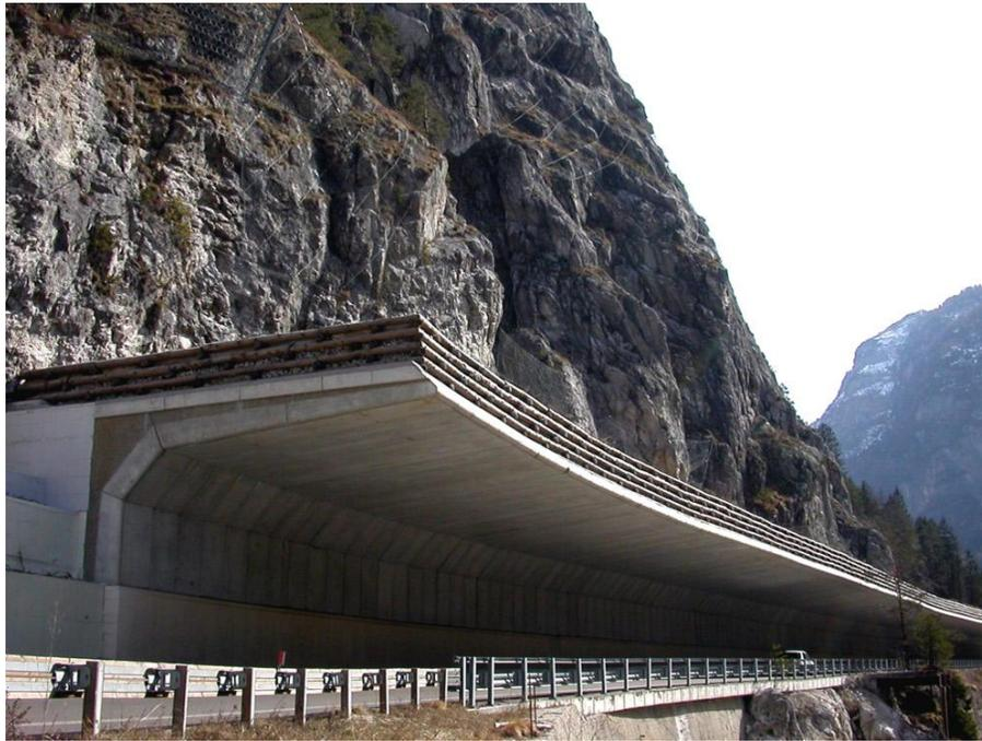
Figura 7.4.5. Túnel falso como medida de mitigación contra la caída de rocas. Recuperado de:
