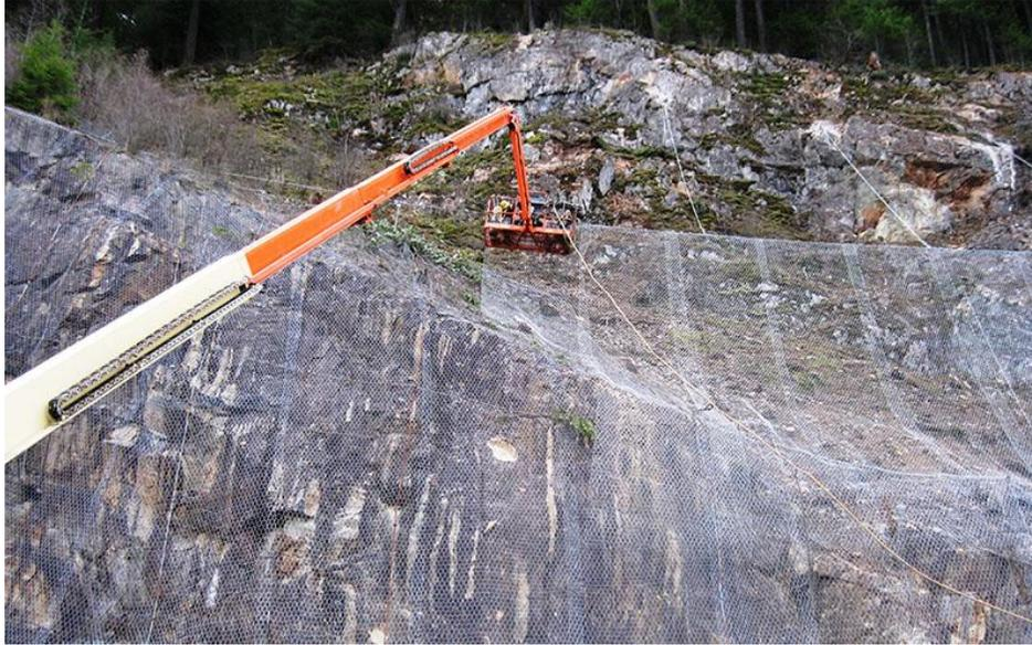
Figura 6.5.1. Instalación de una *draped mesh*. Recuperado de:
