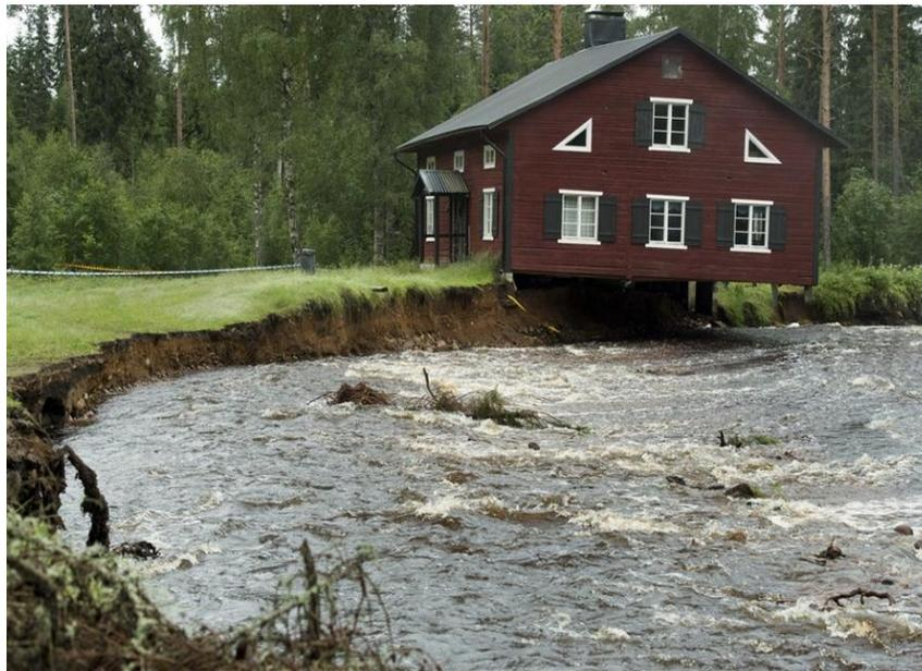
Fig. 2.4 Erosión provocada por intensas lluvias; el incremento del río se traduce en una mayor velocidad de erosión lo que provocó un descalze en la cimentación de la casa por socavación, Suecia. Recuperado de: <http://enriquemontalar.com/cimentacion-descalzada-por-socavacion-un-ejemplo-sueco/>
