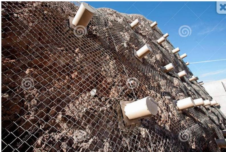
Figura 6.5.2. Patrón de anclaje de una *anchored mesh*. Recuperado de:
