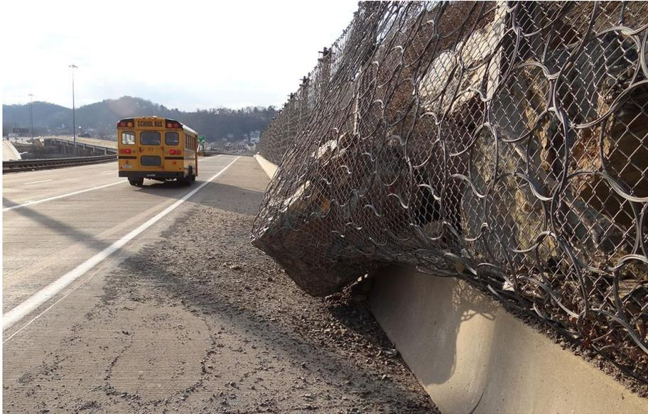
Figura 7.4.2. Combinación entre barreras de concreto y flexibles. Recuperado de: <http://forcesofchange.gfnnet.com/2015/SpringSummer/Rockfall.htm>
