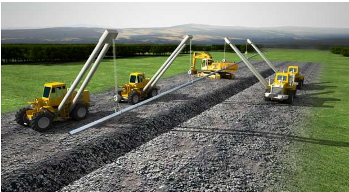
Figura 3.7 Instalación de tuberías para el transporte de \text{CO}_2 , (Global CCS Institute, 2015)
