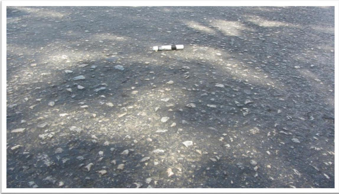
*Fotografía 3.1.2.1.- Exposición del agregado grueso, km 0+700 cuerpo A.*
