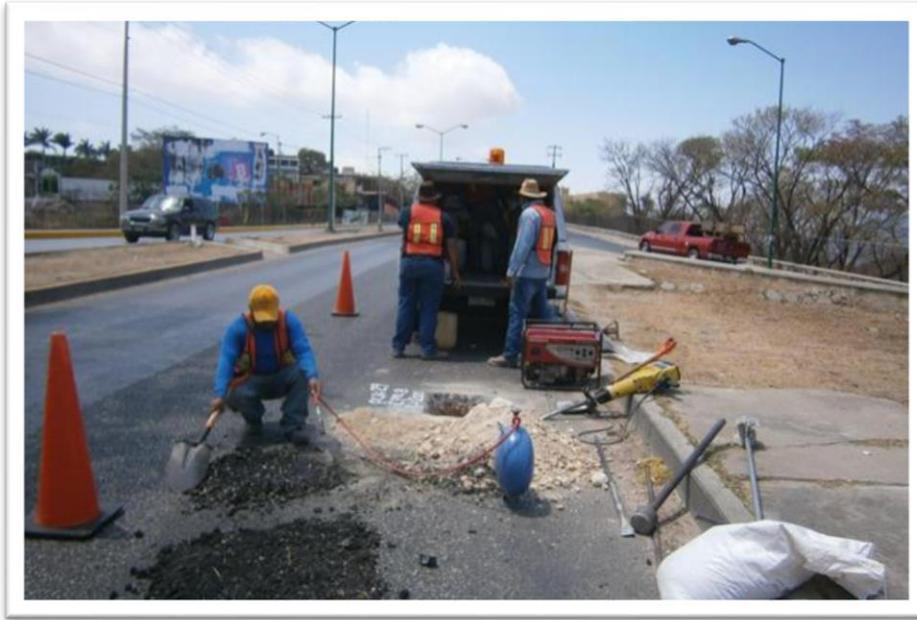
*Fotografía 2.1.1.- Ejecución de pozos a cielo abierto sobre el pavimento, km 0+180.*
