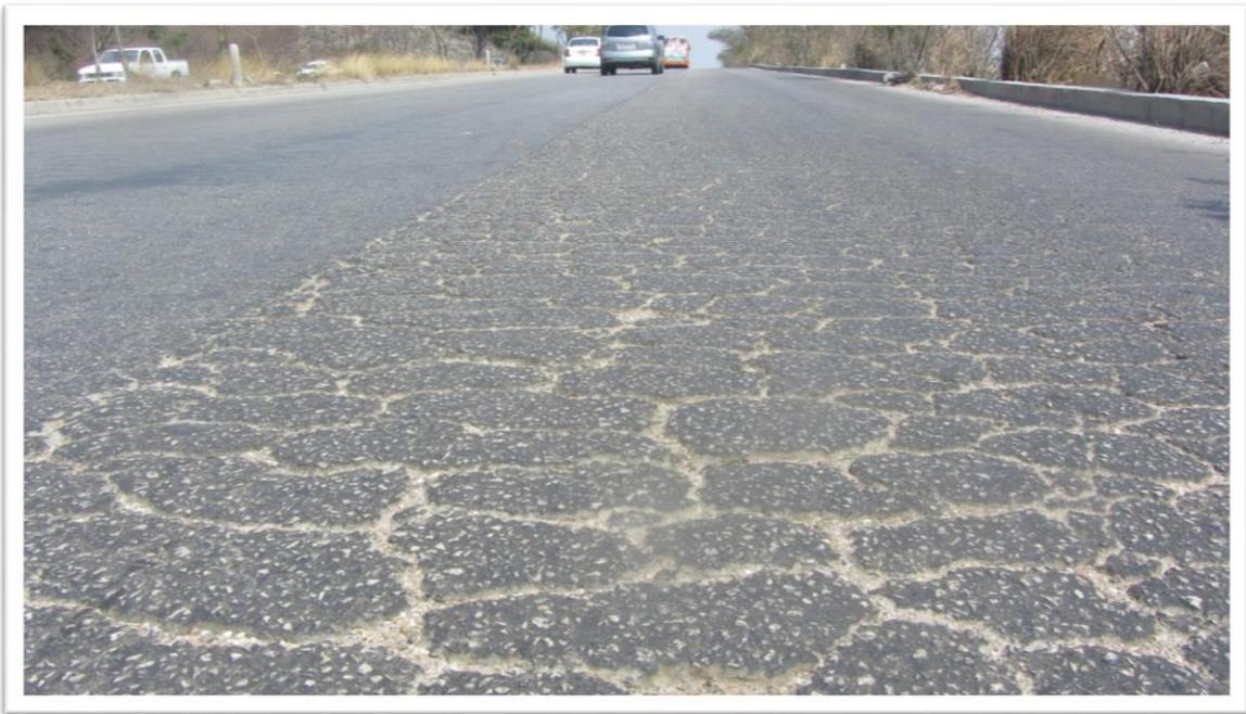
*Fotografía 3.1.2.4.- Agrietamiento tipo piel de cocodrilo, km 5+610 cuerpo B.*
