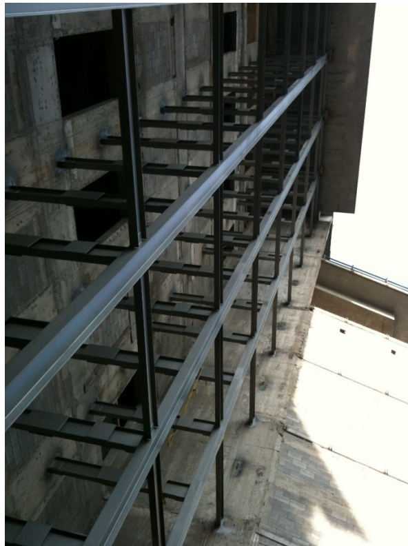
FIG.LL (en la foto se ve los elementos estructurales en cubos de elevadores).
