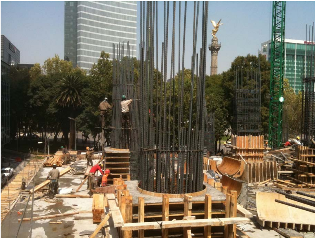
FIG. Z (en la siguiente foto se observa los procesos de obra civil).
