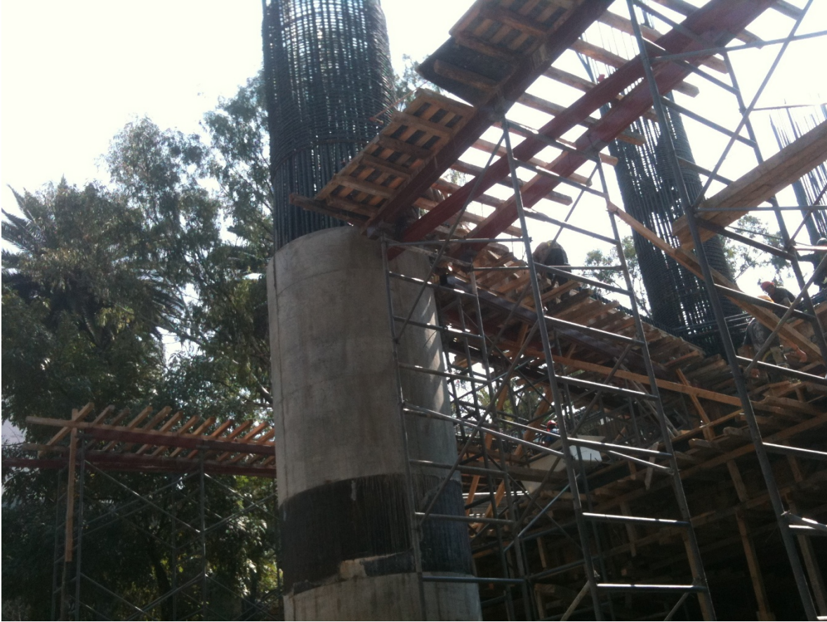
FIG. T (fotografía que muestra los procesos de colado de columnas)
