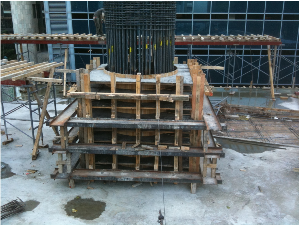
FIG. BB (en la foto se observa el cimbrado de las columnas)
