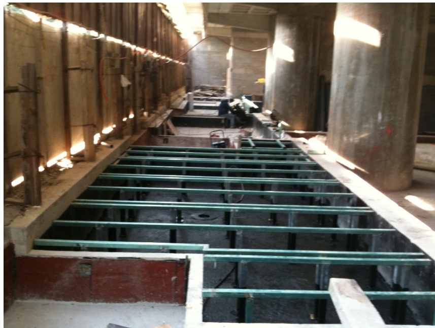
FIG. HH (En la imagen se observa el proceso de colocación de bastidores).
