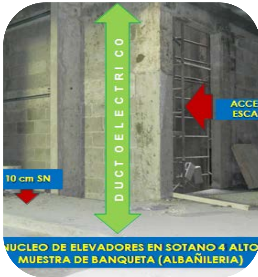
FIG. Q (en esta imagen se observa las actividades de albañilería).
