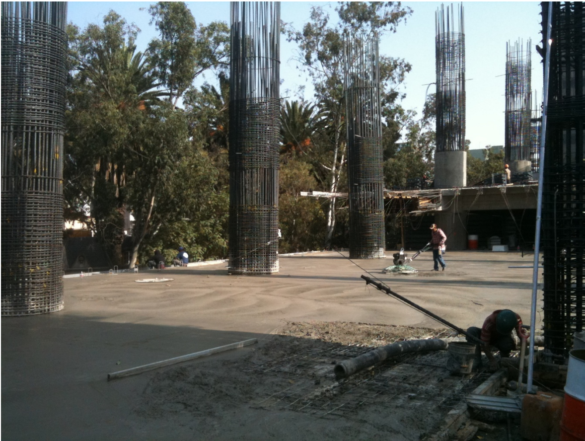
FIG. AA (En la siguiente foto se observa el pulido de la losa).
