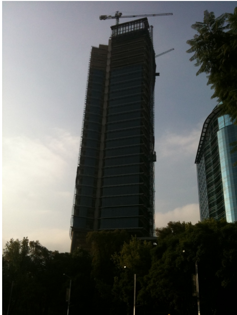
FIG. SS (fotografía panorámica de los trabajos en los cuatro frentes).
