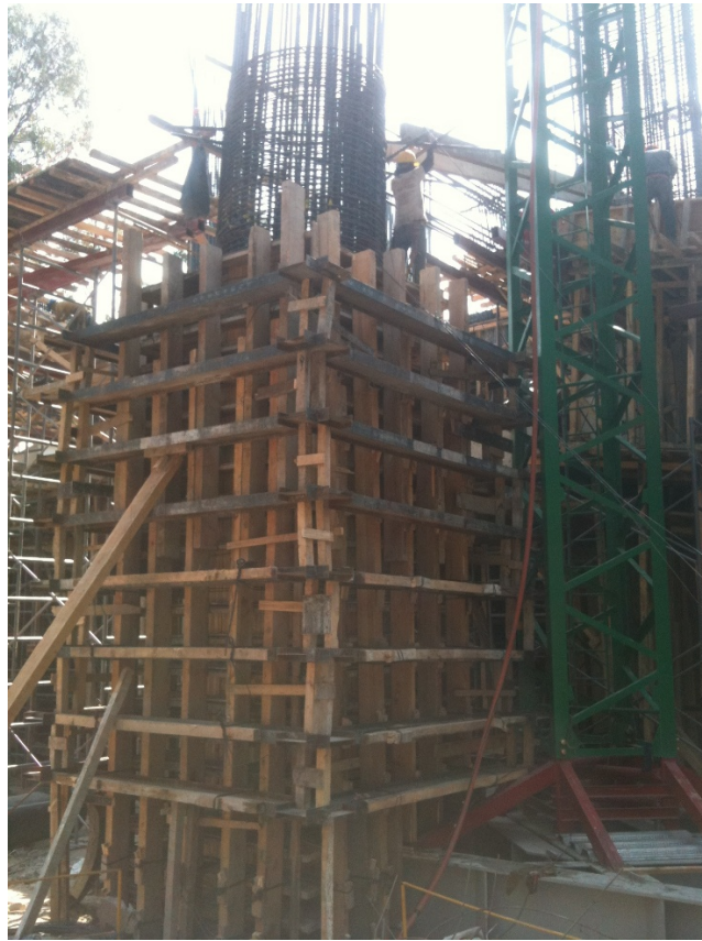
FIG. V (aquí se observa los procesos de la obra civil).
