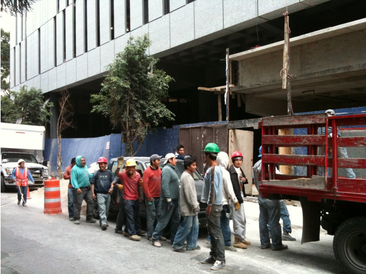
FIG. WW (traslado y almacenamiento del granito de fachadas).
