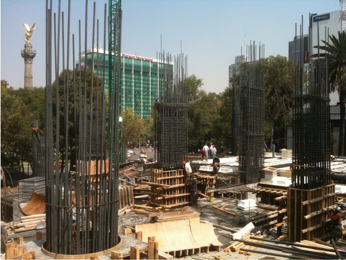
FIG. U (en la siguiente foto se observa el proceso de cimbrado de la losa).
