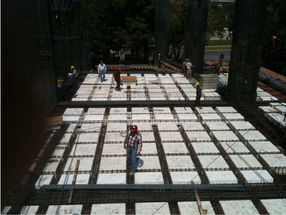
FIG. W (aquí se observa la colocacion del caseton de fibra de vidrio).
