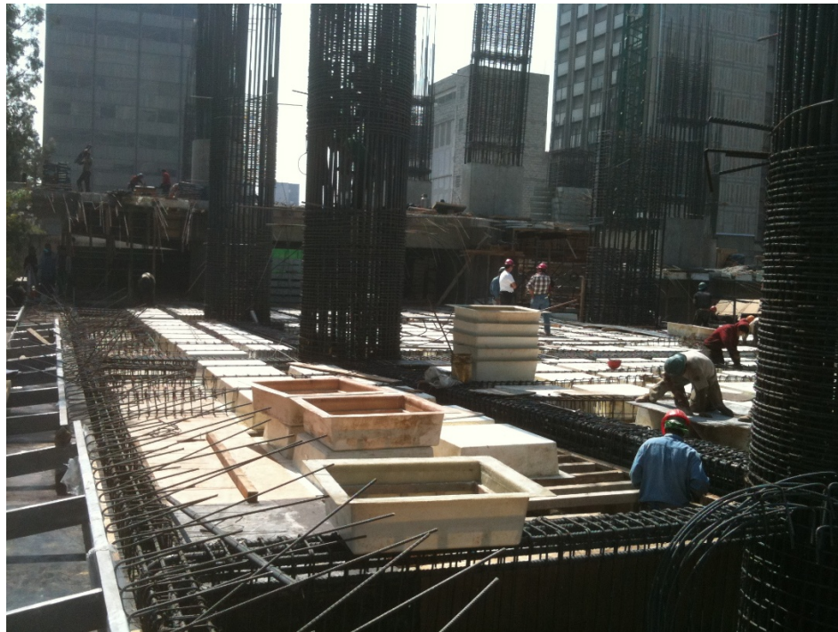
FIG. R (avance para preparativo de colado de P.B.)
