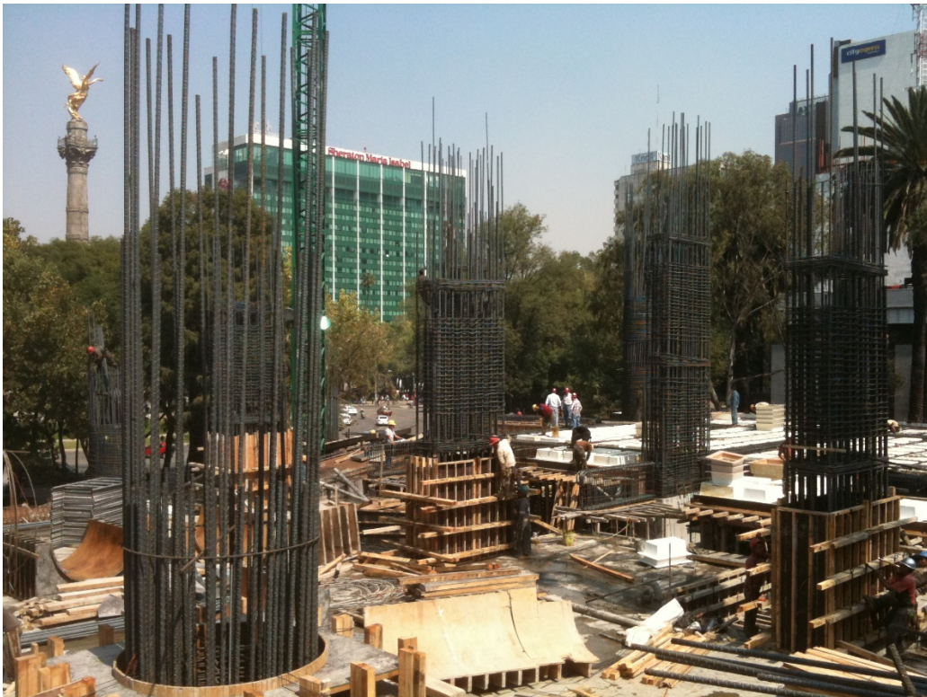
FIG. R (imagen que muestra las actividades de obra civil)
