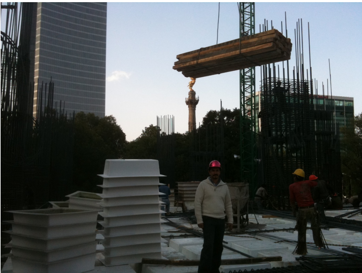
FIG. Y (la imagen se muestra las actividades de maniobras en los cimbrados).
