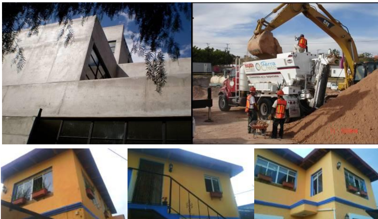
Figura 81. Casa totalmente hecha con Maxeh y casa ampliada a segundo nivel con Maxeh
