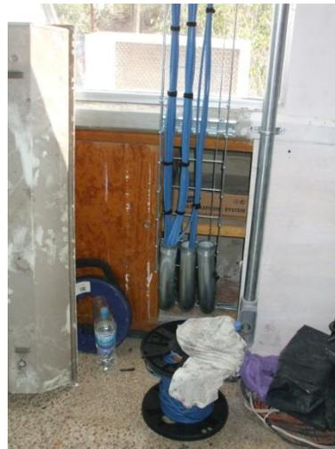
Figura 4.15 Desemboque de tubería Conduit a escalerilla
