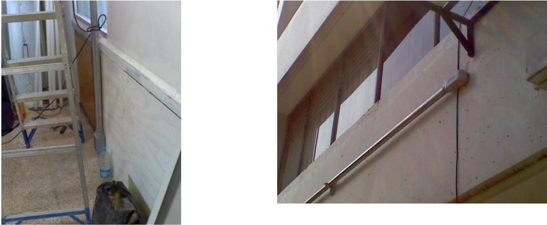
Figura 4.2 Colocación de muros de pino y película polarizada.
