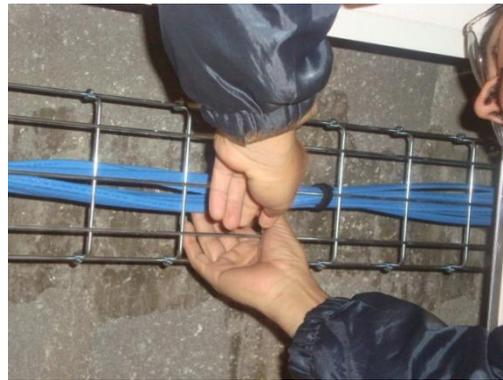
Figura 4.17 Canalización de cableado categoría 6a, por escalerilla y bajo piso.
