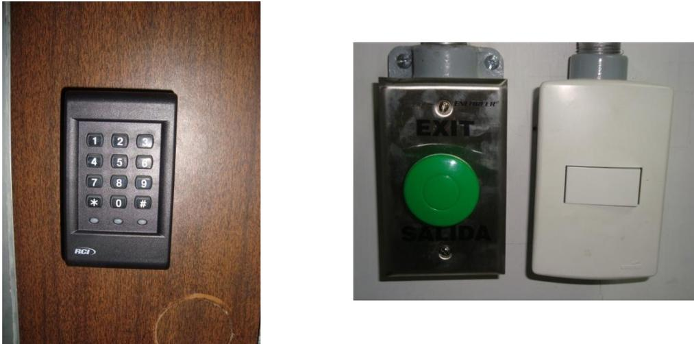
Figura 4.6 Sistema de acceso de seguridad
