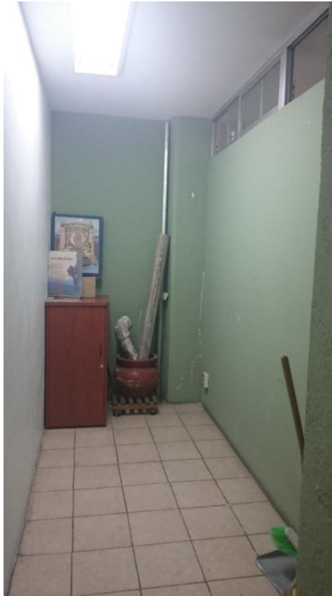
Figura 11. Espacio propuesto para ser habilitado y acondicionado para funcionar como cuarto de telecomunicaciones
