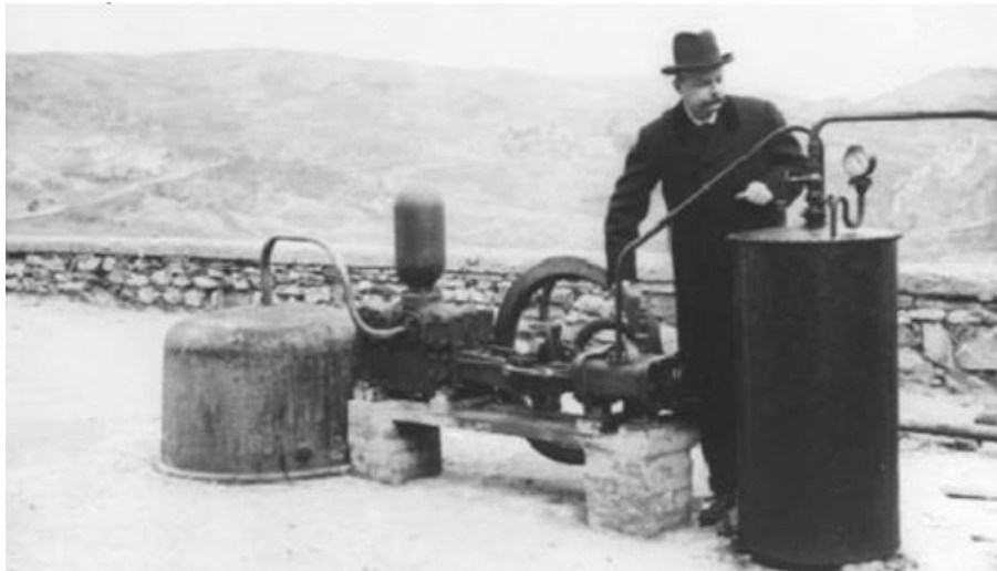
Fig. 1. 5 Primera instalación de generación de energía eléctrica, Larderello 1904 [2]
