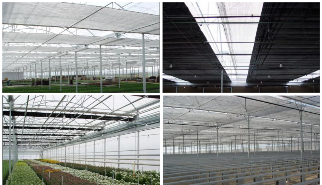
Fig. 3. 8 Pantallas y sombreo – pantallas térmicas [47]
