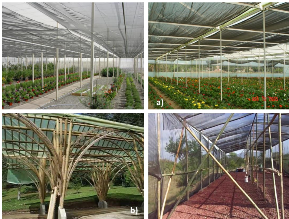
Fig. 2. 6 Invernadero casa sombra a) Estructura acero galvanizado b) Estructura rustica (madera)
