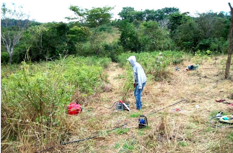
Fotografía 21. Sitio donde se ubicó el punto de atribución del SEV 3, localizado en la porción centro este de la casa de máquinas. Vista al sureste
