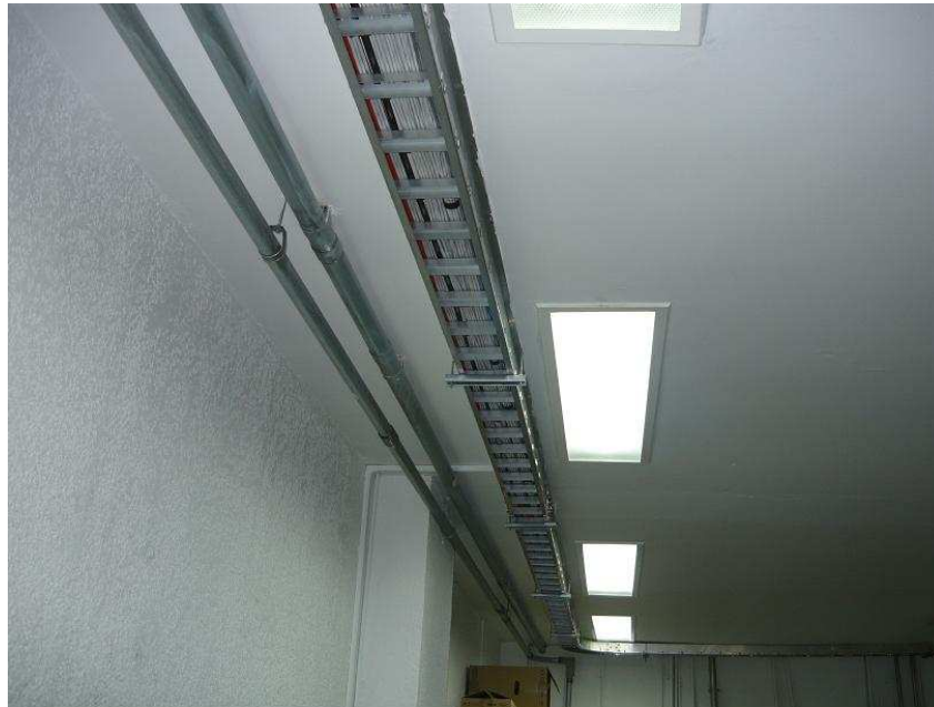
Imagen 3.10 Sistema de cableado estructurado tipo horizontal
