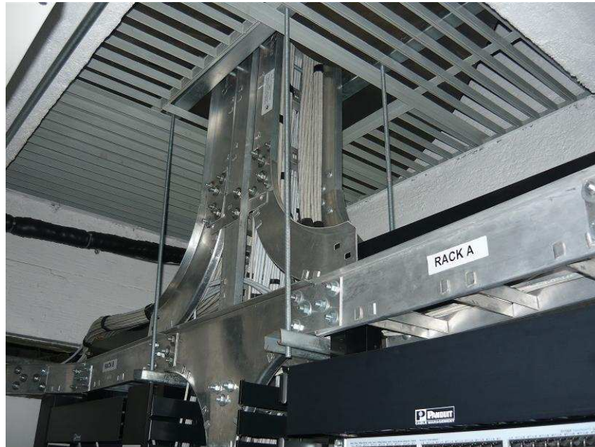
Imagen 3.11 Cableado vertical
