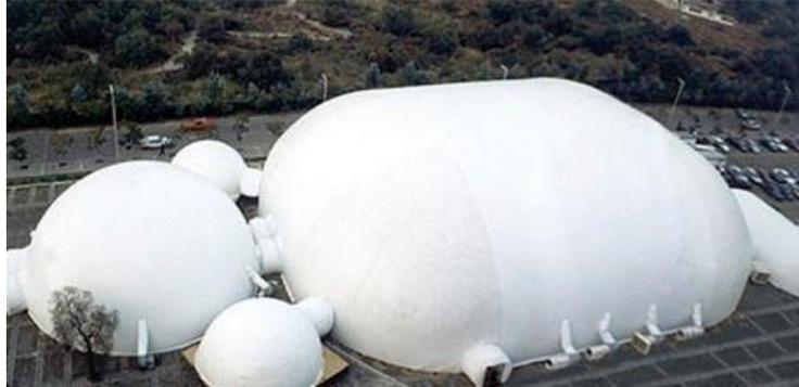
*Figura 2.5 Estructura neumática en Cuicuilco, D.F. (Seman Baker, sitio web)*
