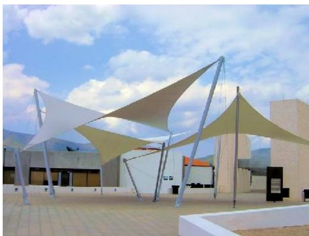
*Figura 1.1 Tenso-estructura con forma de paraboloides hiperbólicos*
