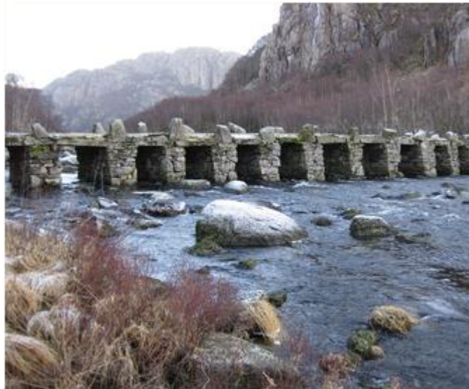
Figura 1.1 Puente de piedra, Sirdal, Noruega
