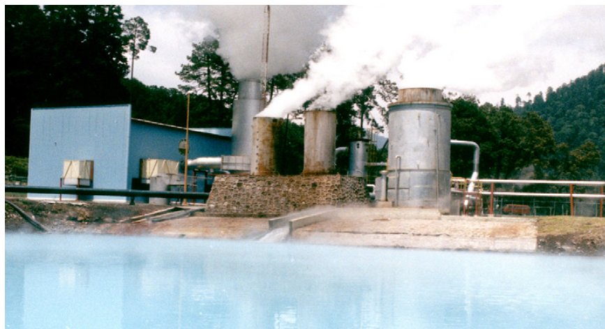
Figura 2.7 Planta geotermoelectrica Los Azufres Michoacán
