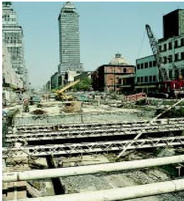
Figura 1.8 Construcción de la línea 8 del STC Metro
