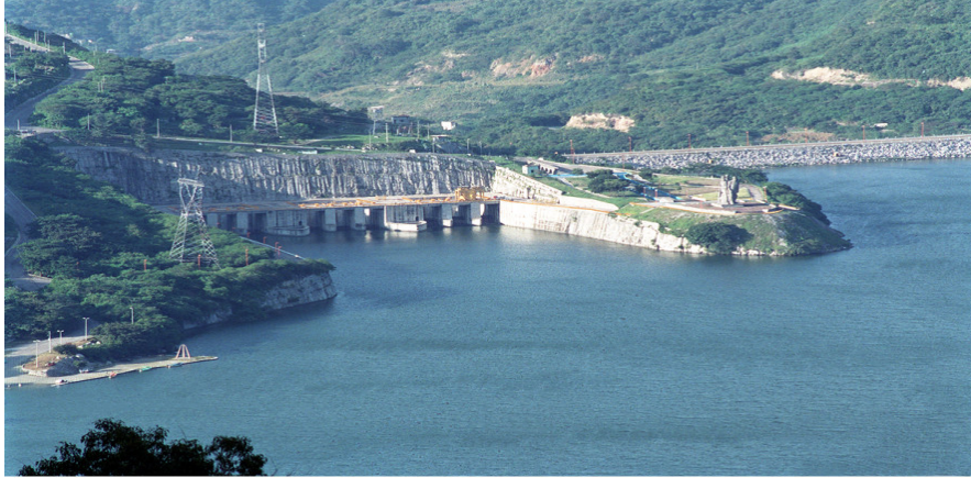
Figura 2.6 Planta hidroeléctrica Chicuasén Chiapas
