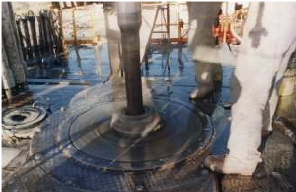
Figura 4.1 Etapa de perforación de un pozo petrolero
