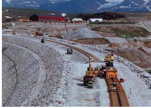
Figura 1.9 Construcción de la presa Storglomvath Noruega con núcleo impermeable de concreto asfáltico Hoeg, K. (1993).
