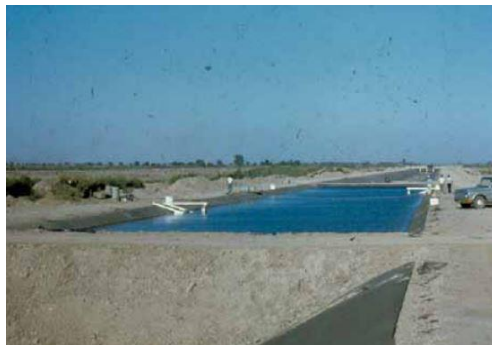
Figura 1.8 Colocación de concreto asfáltico longitudinalmente en estanque (Orozco R., 2008)
