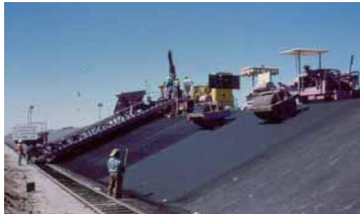
Figura 1.7 Extendido y compactación de concreto asfáltico en el talud de un canal (Orozco R., 2008)
