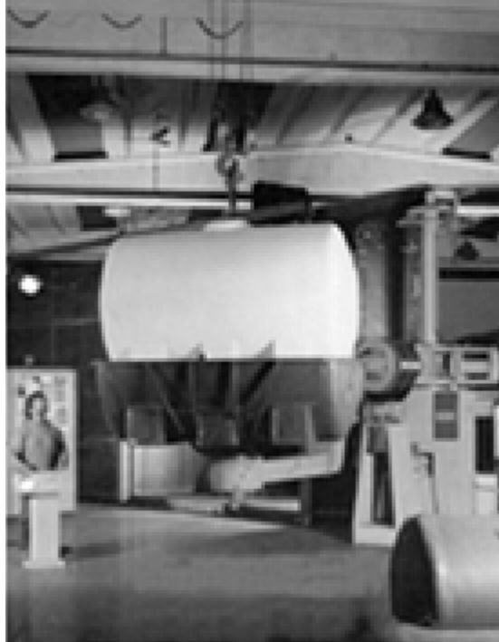
Figura 6.2 Desmolde de una nodriza horizontal. Imagen tomada de Rotoplas S.A. de C.V
