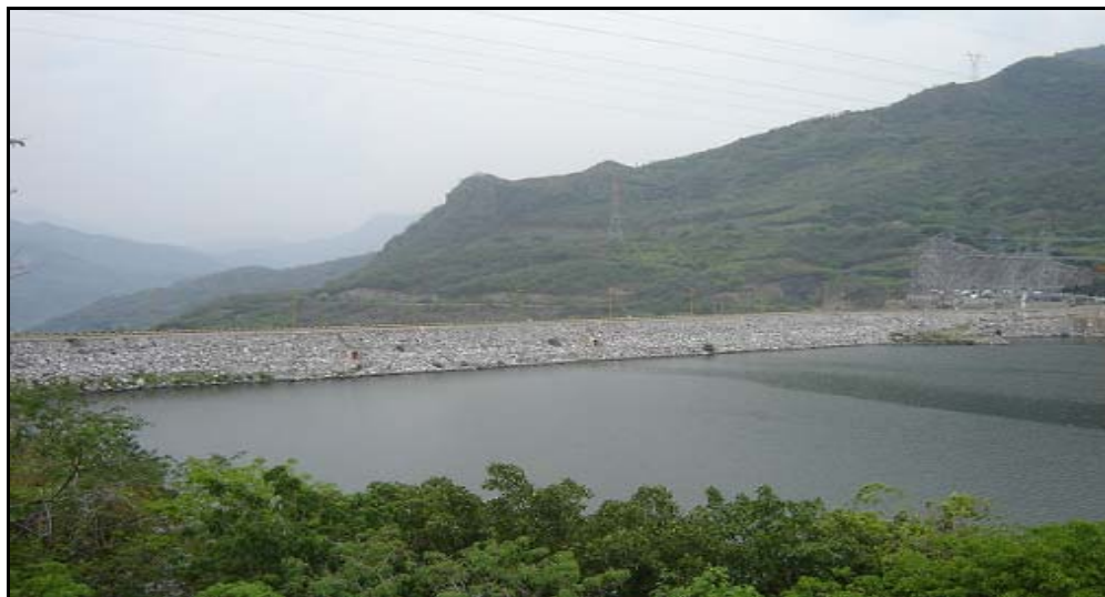
Fotografía 1.4 Aguas arriba de la Cortina
