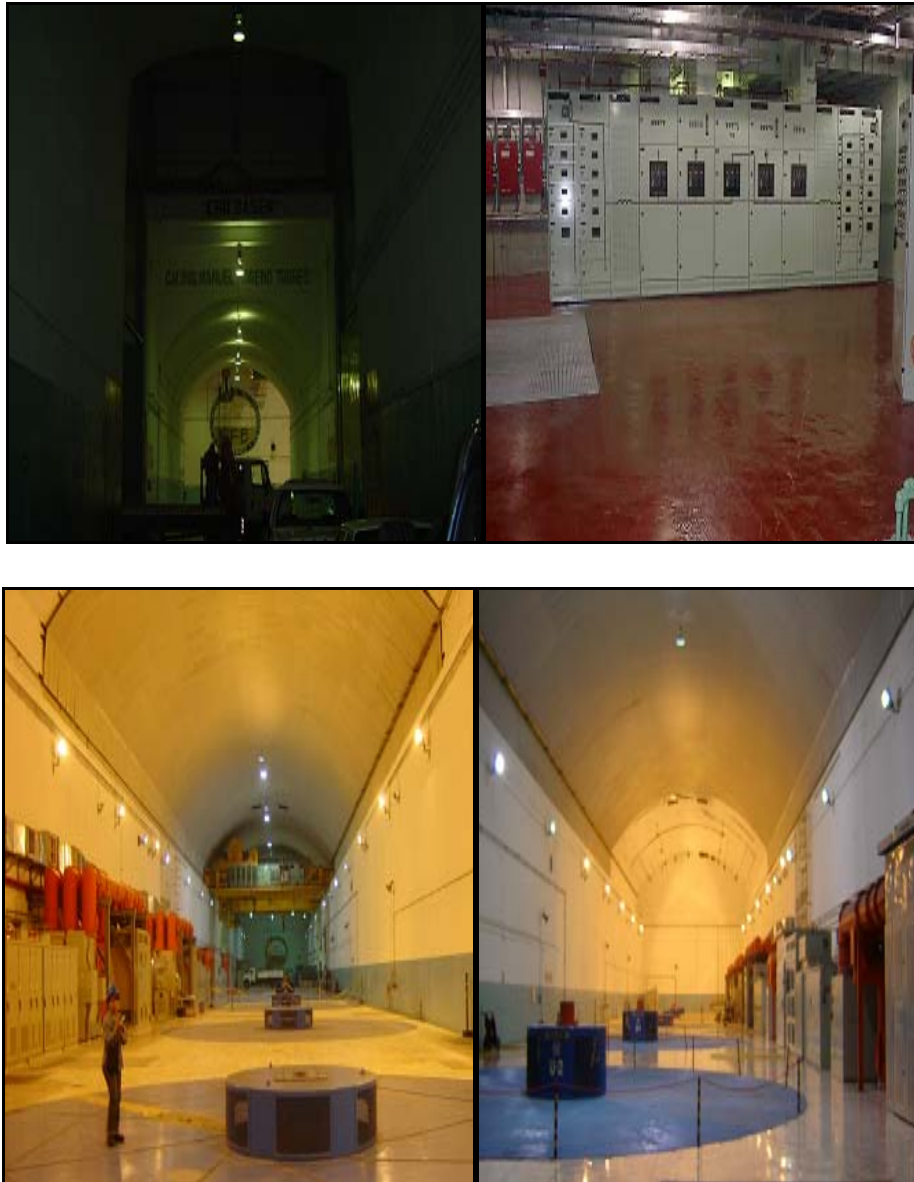
Fotografía 1.8 Casa de Máquinas
