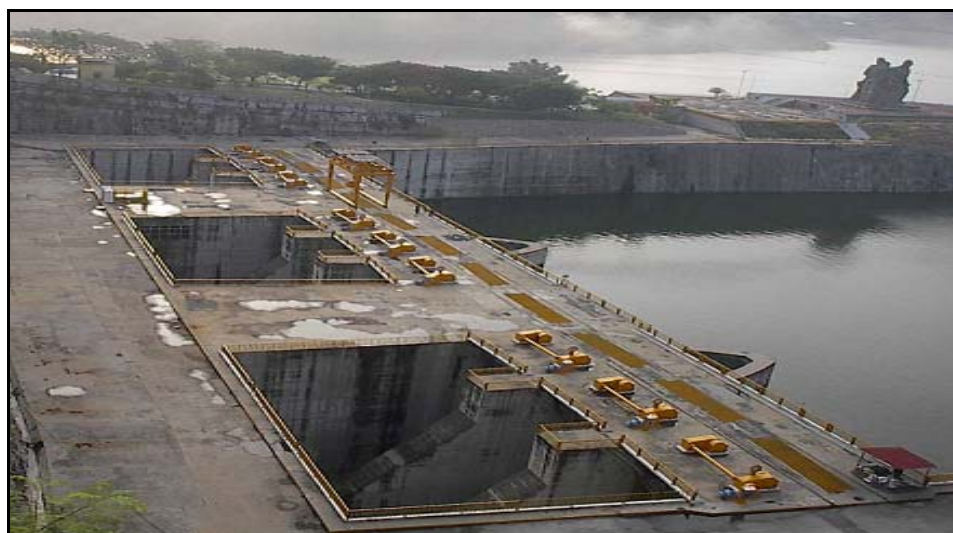
Fotografía 1.5 Obra de Excedencias
