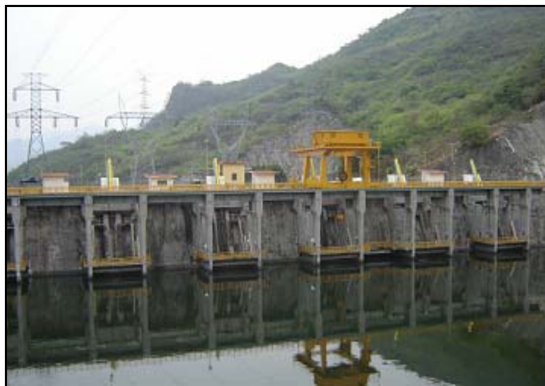
Fotografía 1.7 Obra de Toma
