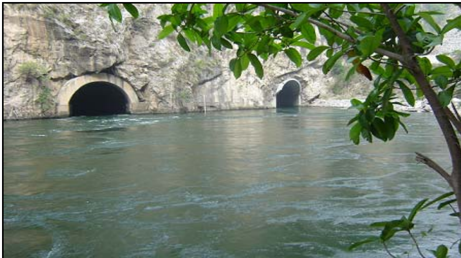
Fotografía 1.10 Túneles de Desfogue
