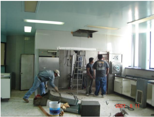
DESMANTELAMIENTO DE AUTOCLAVES DE ESTERILIZACION DEL CEYE.
