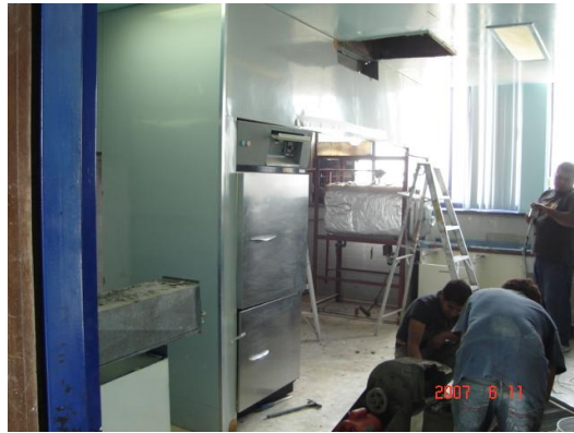
DESMANTELAMIENTO DE AUTOCLAVES DE ESTERILIZACION DEL CEYE.
