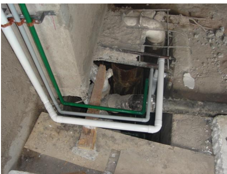
Instalaciones Especiales (Gases Medicinales)
