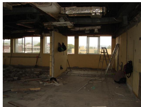
TRABAJOS DE DEMOLICIONES DE MUROS DIVISORIOS
