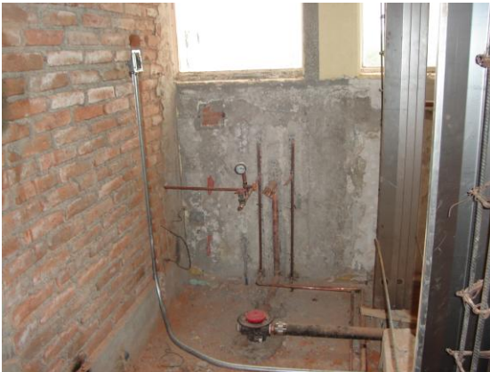
Instalaciones Hidráulicas y Pruebas de Presión
