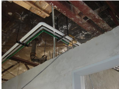
Instalaciones Especiales (Gases Medicinales)
