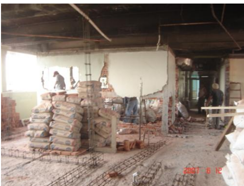
TRABAJOS DE DEMOLICIONES DE MUROS DIVISORIOS
