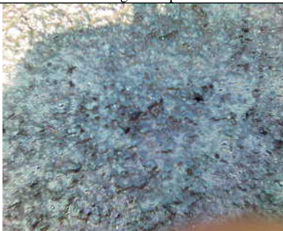
Rompimiento del riego de taponamiento
