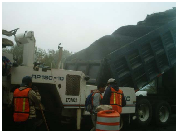
Carga de concreto asfáltico a la pavimentadora (Finisher)
