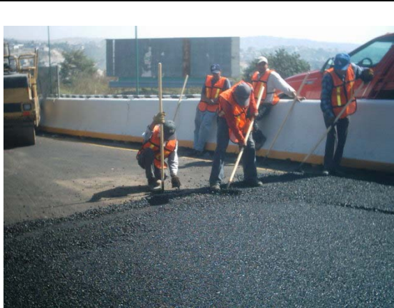
Rastrilléo del concreto asfáltico tendido de la base negra
