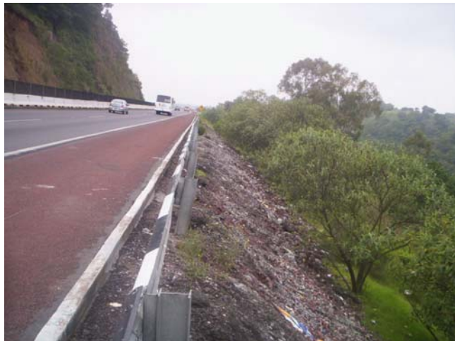
Fotografía No. 2 Secciones de corte y terraplén.
