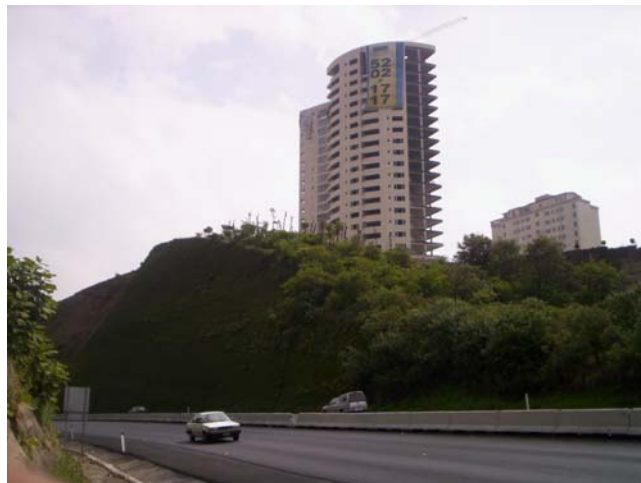
Fotografía No. 10 Existen zonas con cortes de hasta 25m.
