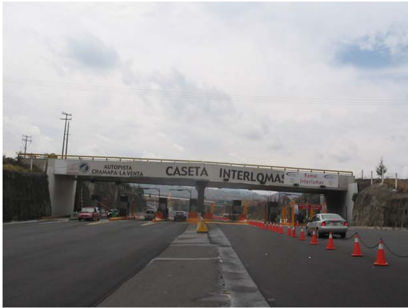
Fotografía No. 13 Caseta de Interlomas (km. 35+000) Ubicada en el entronque con Interlomas
