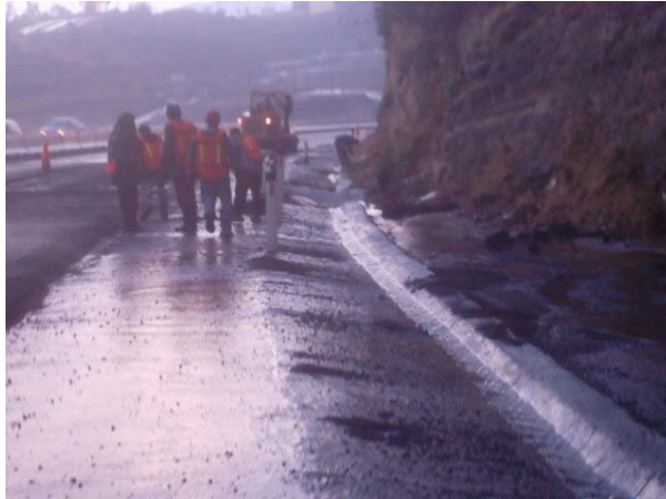
Fotografía No. 5 La lluvia constituyó un factor adverso durante el tendido de asfalto
