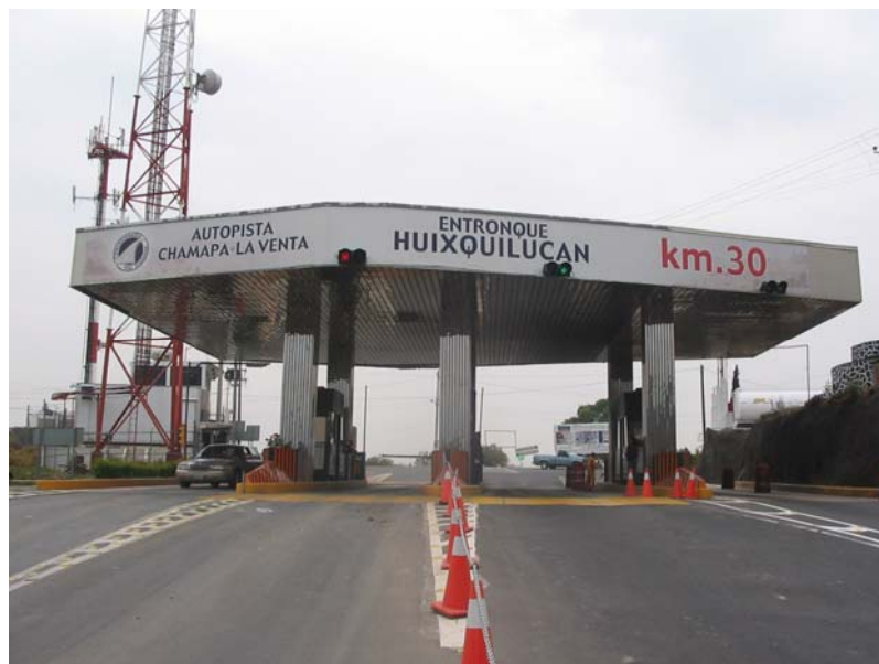
Fotografía No. 12 Caseta de Huixquilucan (km. 30+000) Ubicada en el entronque con Huixquilucan
