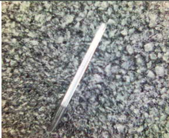
Apariencia de la microcarpeta antes de colocar el riego de taponamiento
