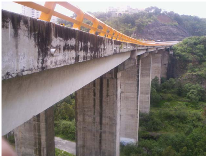
Fotografía No. 16 Puente del. Km. 31+200
