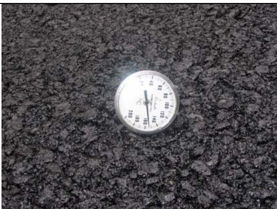
Temperatura de tendido del concreto asfáltico de la Base Negra (130-150°C)
