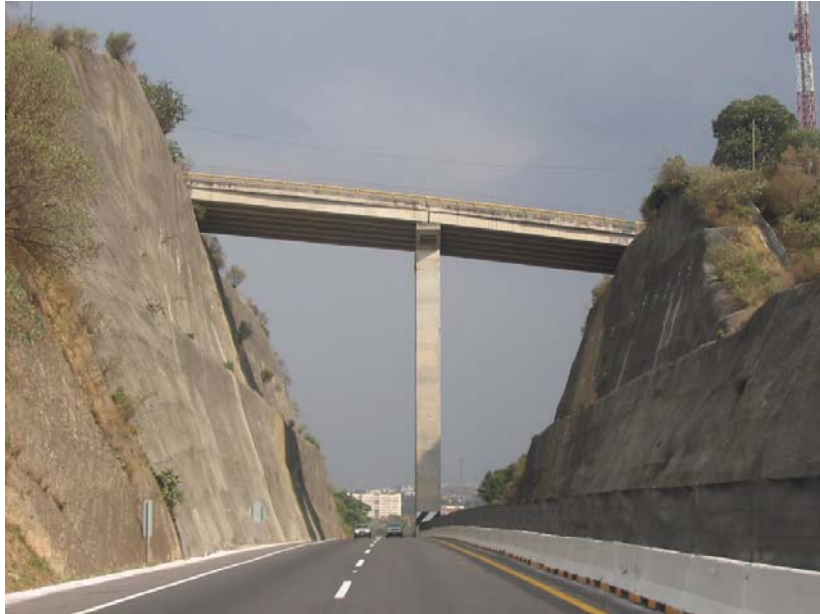
Fotografía No. 15 Puente del Ahorcado. Km. 30+100
