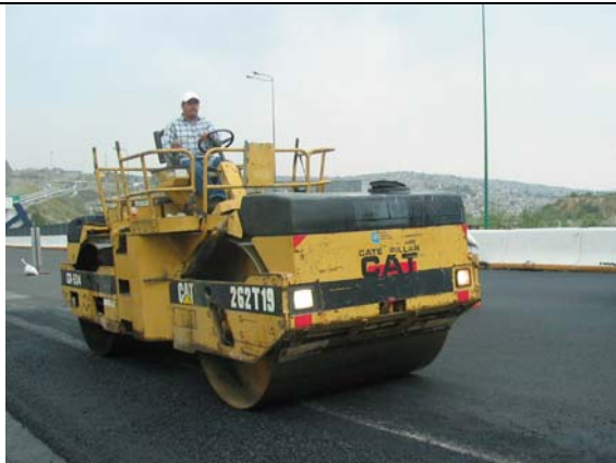
Compactación de la base negra con la máquina de rodillos
