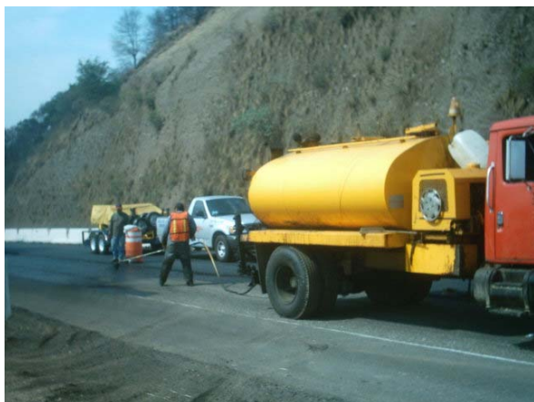
Riego de Impregnación sobre la superficie fresada
