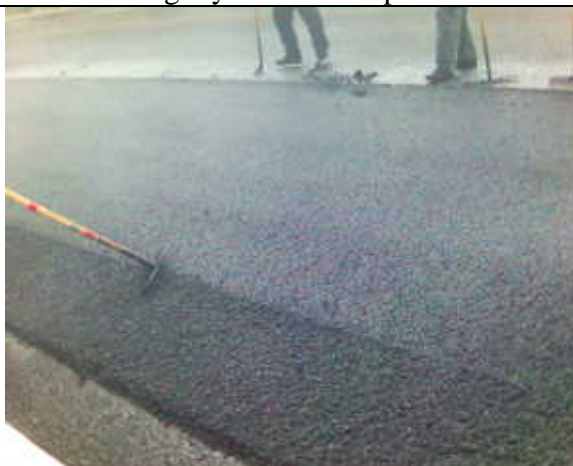
Rastrilléo para regular la regularidad del tendido de la microcarpeta
