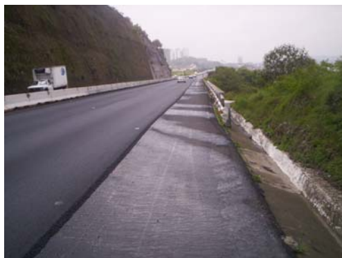
Fotografía No. 9 Esgurrimiento y cuneta
