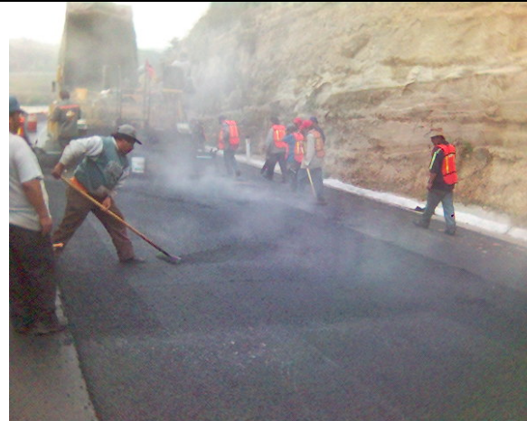
Tendido y rastrilleo de microcarpeta (3cm de espesor)
