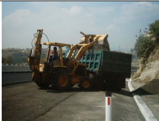
Carga de material de fresado
