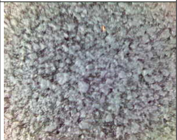
Apariencia de la superficie con el riego de taponamiento cuando ya rompió la emulsión
