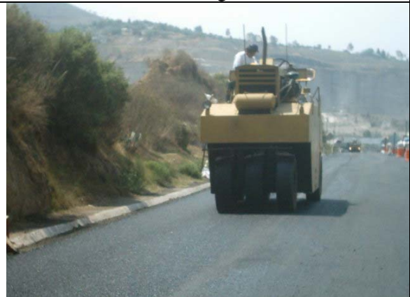
Compactación de la base negra con la máquina de neumáticos
