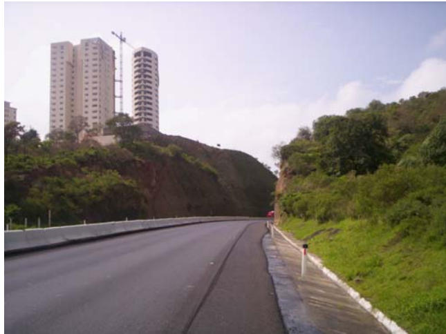
Fotografía No. 1 La autopista atraviesa zonas con lomerío fuerte
