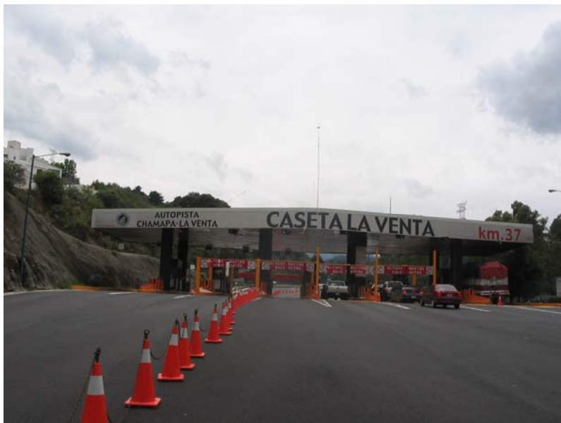
Fotografía No. 14 Caseta de La Venta (Km 37+000)
