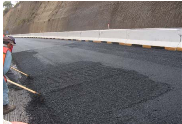
Rastrilléo del concreto asfáltico tendido de la base negra
