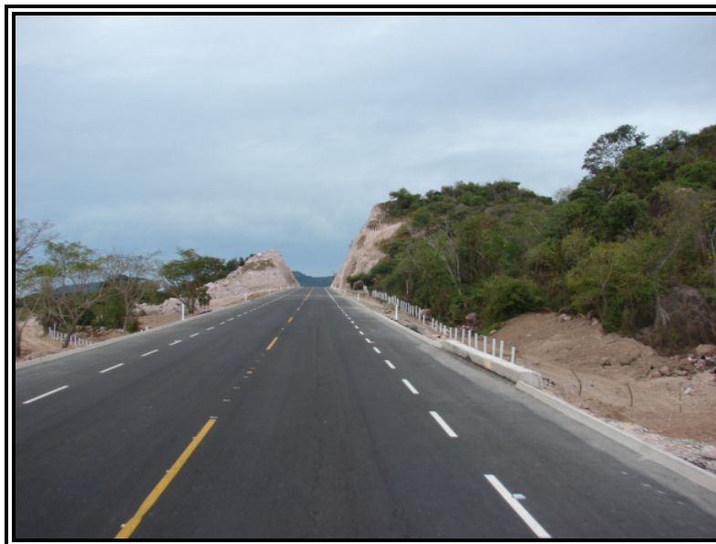
Figura 2. Calzada de una Autopista
