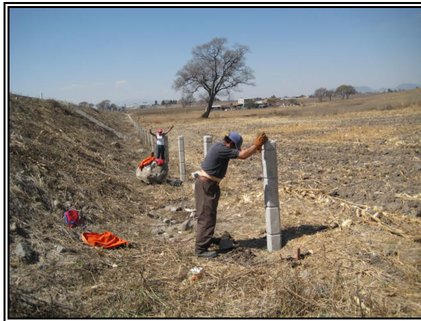
Figura 14. Reparación de Cercado del Derecho de Vía
