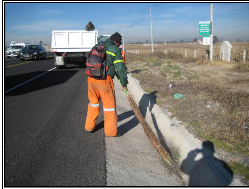
Figura 17. Limpieza y/o Desazolve de Cunetas
