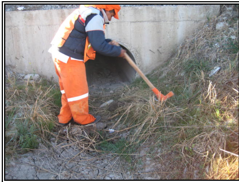
Figura 16. Limpieza y/o Desazolve de Alcantarillas
