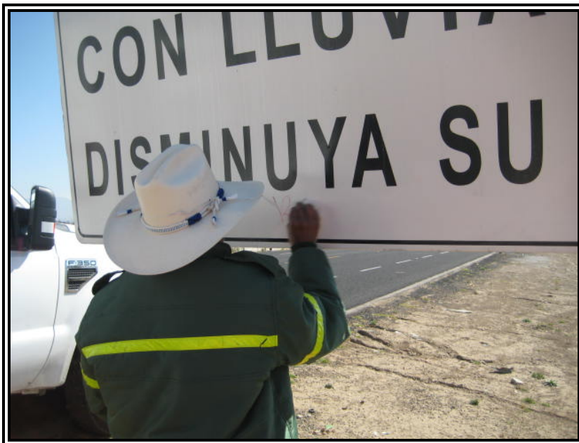
Figura 12. Limpieza de Señalamiento Vertical Bajo
