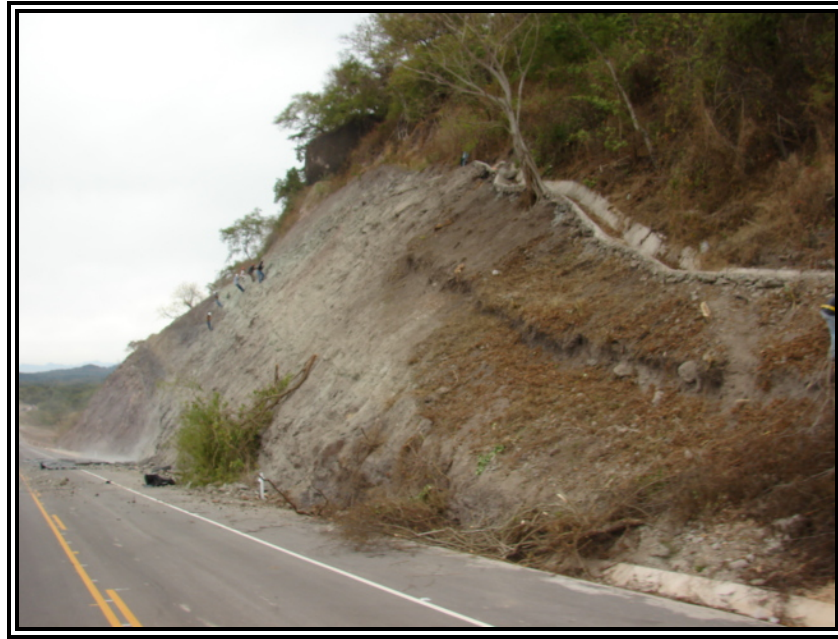
Figura 6. Contracuneta en la parte superior del corte
