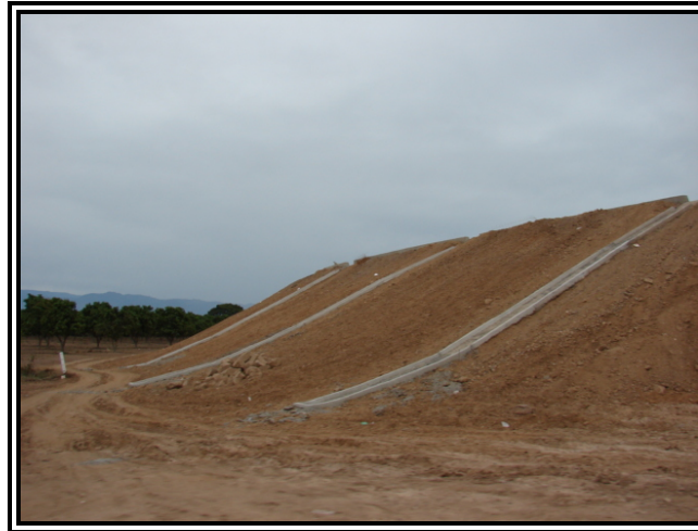
Figura 8. Talud en Terraplén con lavaderos de concreto
