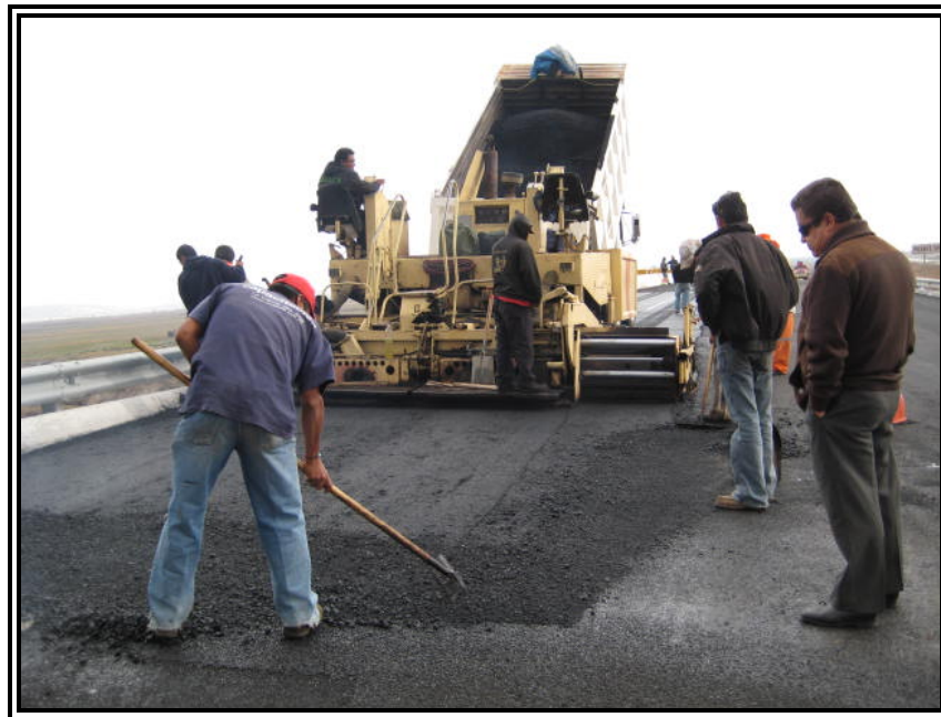
Figura 23. Tendido de Mezcla Asfáltica
