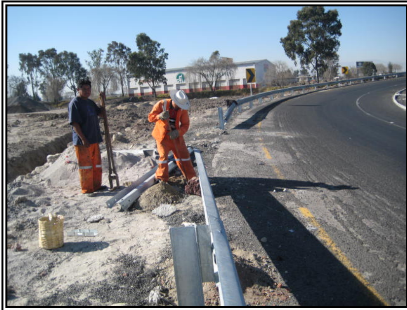
Figura 11. Sustitución de Defensa Metálica
