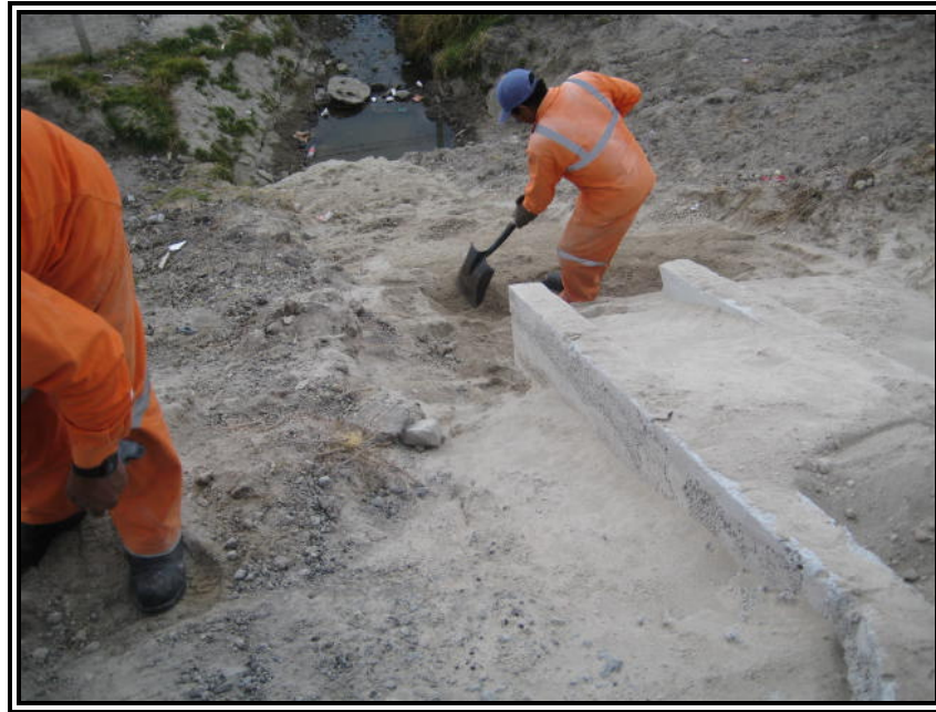
Figura 19. Limpieza de Lavaderos
