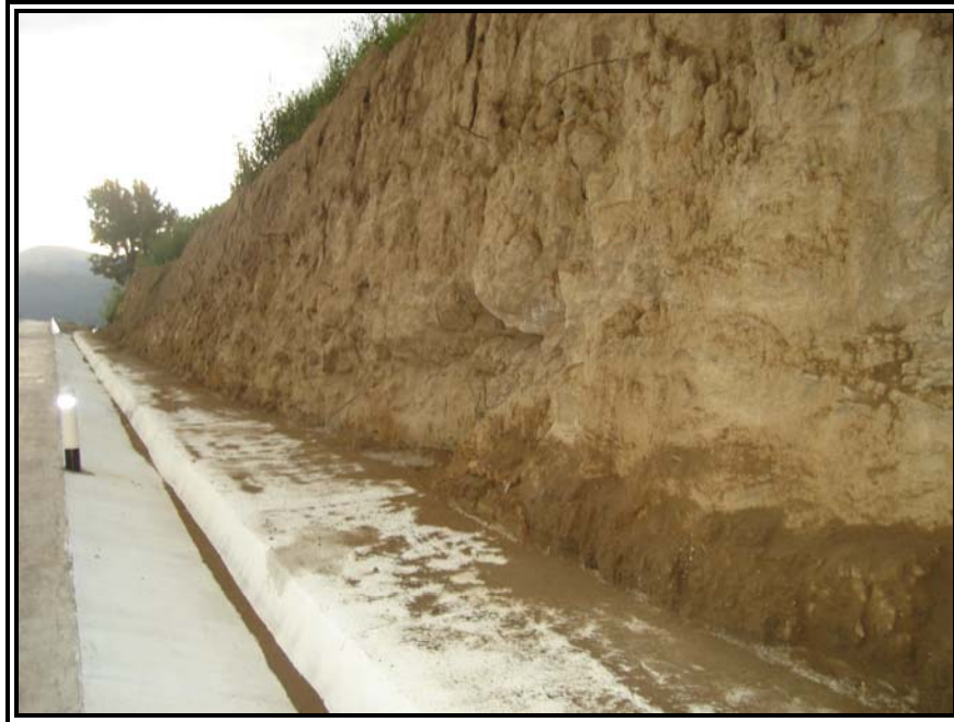
Figura 48. Banqueta al pie del Talud
