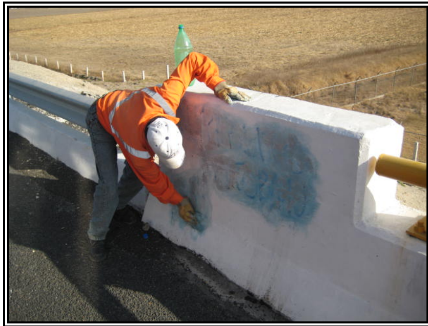
Figura 13. Limpieza de Guarniciones en Puentes
