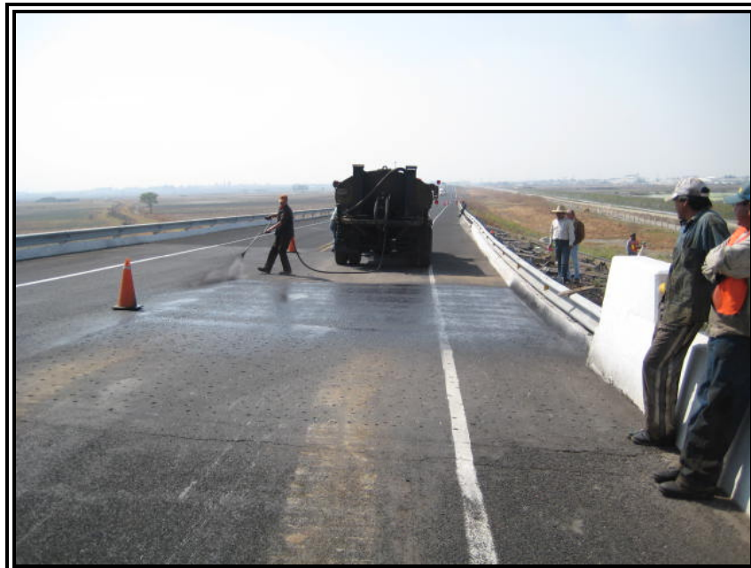
Figura 22. Riego De Liga Entrada Pte. Dren Ameyalco
