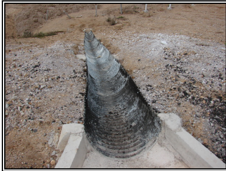
Figura 4. Lavadero de sección circular
