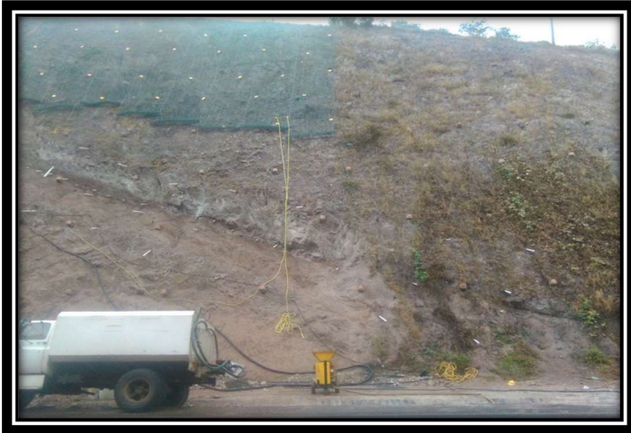
Fig. 25 Talud km 207+120 al 207+180 (vista antes de los trabajos)
