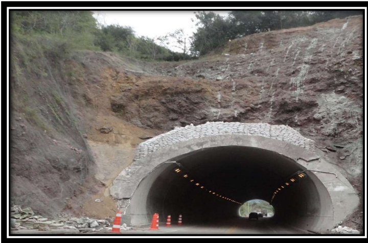
Fig. 29 Talud km 195+550 (vista antes de los trabajos)
