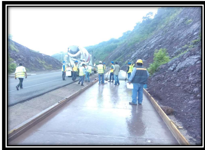
Fig. 33 Talud km 197+500 (vista durante de los trabajos)
