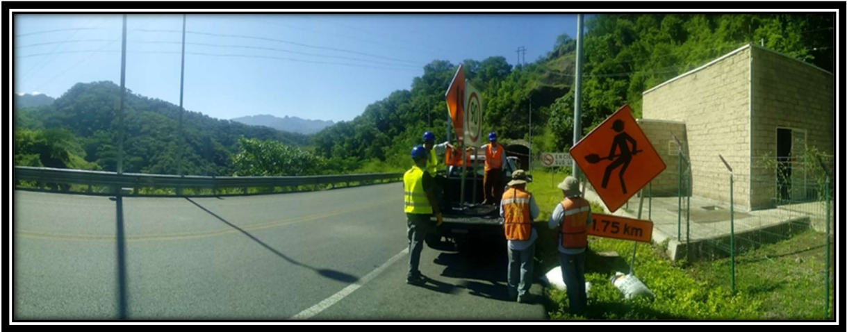
Fig.6 Instalación de señalamiento de protección de obra (trabajos a 1.75 km)
