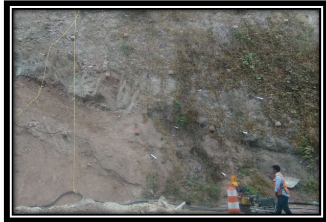
Fig. 24 Talud km 207+120 al 207+180 (vista después de los trabajos)
