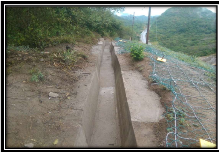
Fig. 40 Talud km 207+120 al 207+180 (vista después de los trabajos)
