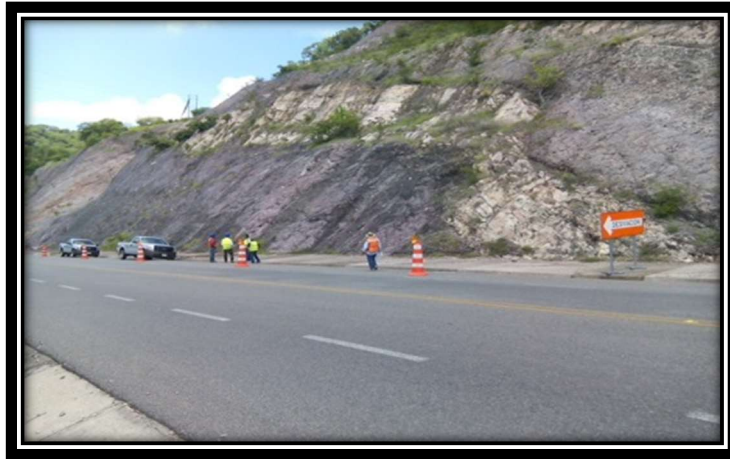
Fig. 8 Señalamiento de protección de obra en zona de trabajos
