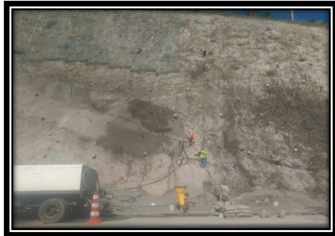
Fig. 26 Talud km 207+120 al 207+180 (vista durante de los trabajos)
