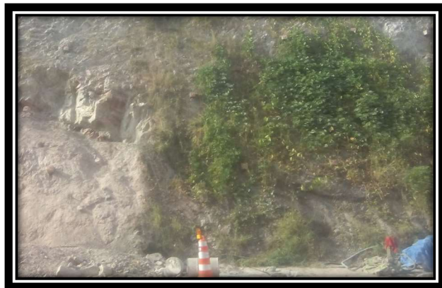
Fig. 22 Talud km 207+120 al 207+180 (vista antes de los trabajos)
