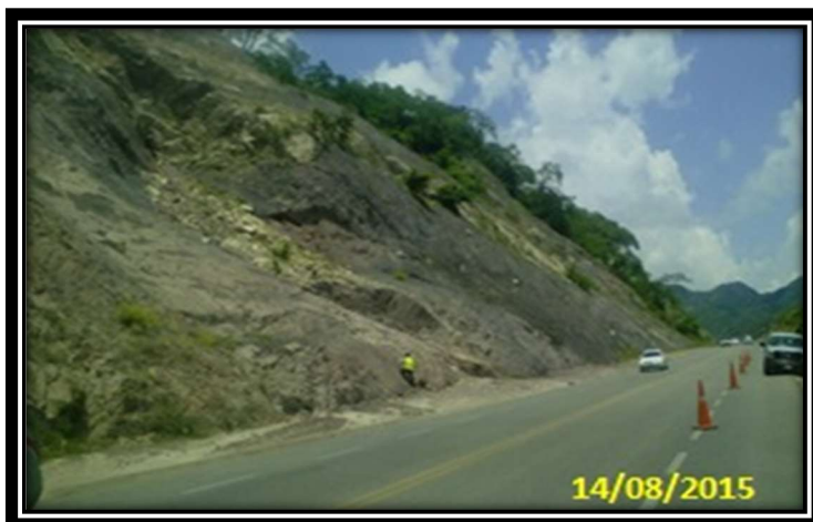
Fig. 12 Talud km 197+500 al 197+950 (amacice de taludes km 197+850)
