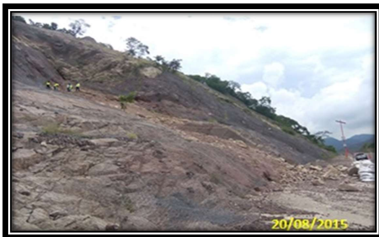
Fig. 13 Talud km 197+500 al 197+950 (trabajos de amacice)
