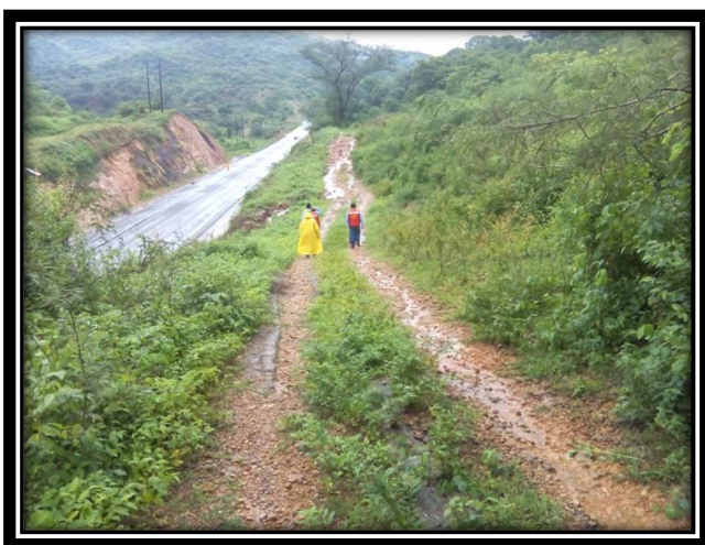
Fig. 35 Talud km 196+100 al 196+400 (vista antes de los trabajos)
