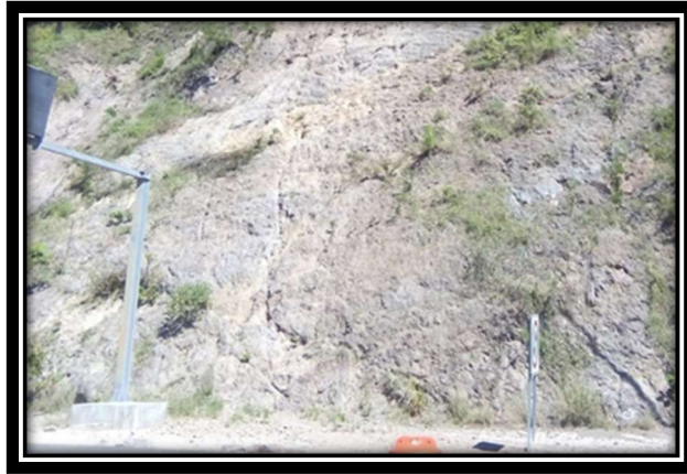
Fig. 19 Talud km 163+950 al 164+100 (vista antes de los trabajos)
