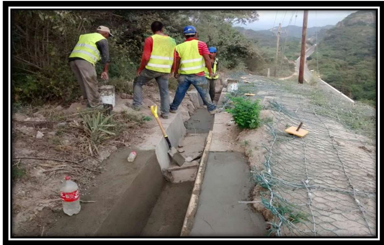
Fig. 39 Talud km 207+120 al 207+180 (vista durante de los trabajos)
