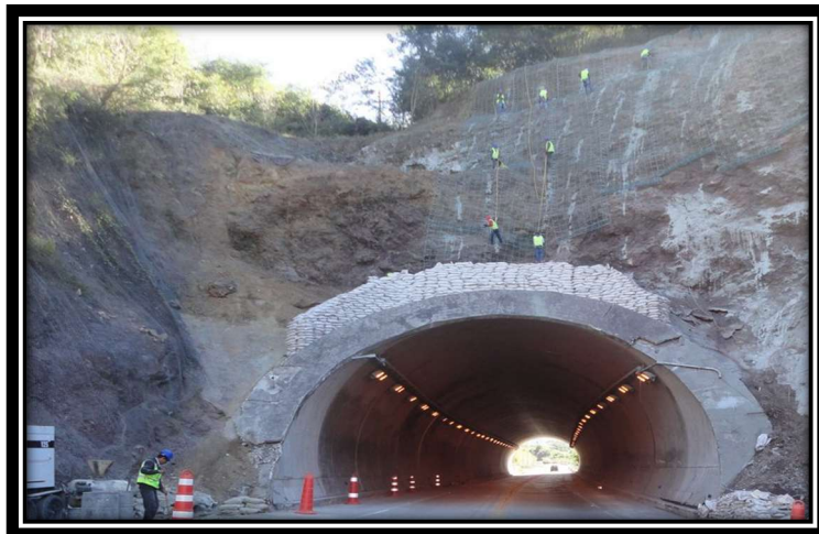
Fig. 30 Talud km 195+550 (vista durante de los trabajos)
