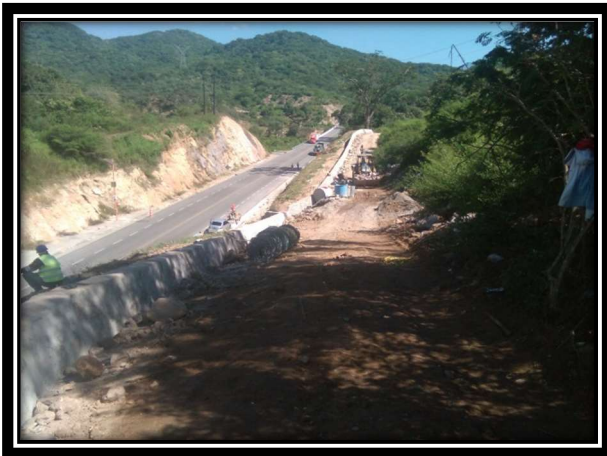
Fig. 37 Talud km 196+100 al 196+400 (vista después de los trabajos)
