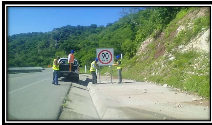
Fig.6 Instalación de señalamiento de protección de obra (trabajos a 1.75 km)
