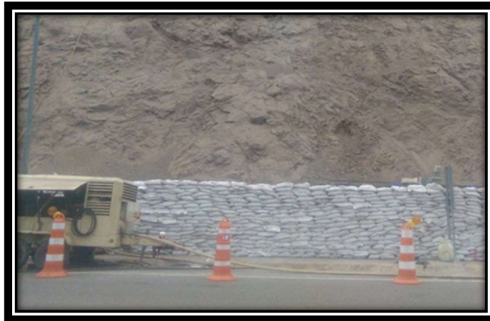
Fig. 11 Talud km 163+950 al 164+100 (barrera de protección km 164+000)
