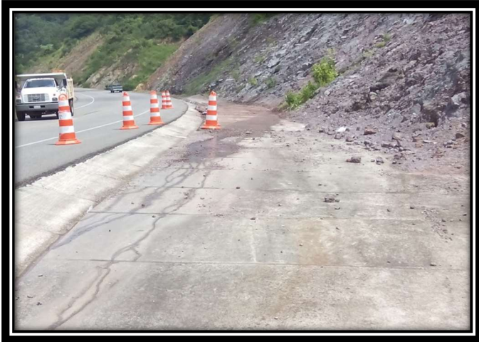
Fig. 32 Talud km 197+500 (vista antes de los trabajos)
