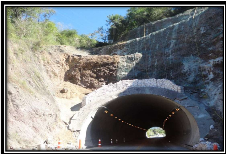
Fig. 31 Talud km 195+550 (vista después de los trabajos)
