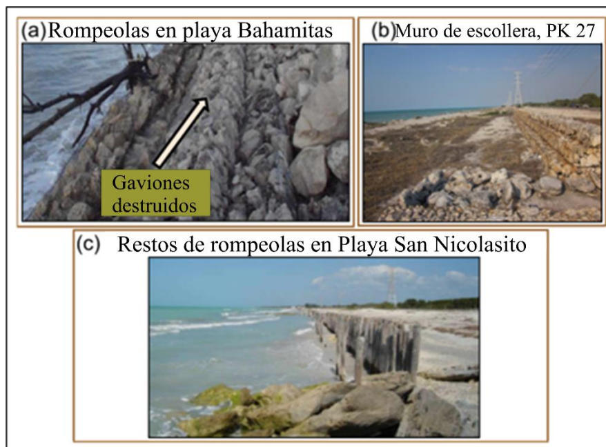
Figura X.34. Estructura de escollera en Isla del Carmen: (a) Rompeolas en playa Bahamitas (modificado de Bolongaro A. et al., 2007); (b) Muro de escollera en PK 27, para proteger la carretera que cruza la isla; (c) Restos de rompeolas en playa San Nicolasito (modificado de Bolongaro et al., 2007).
