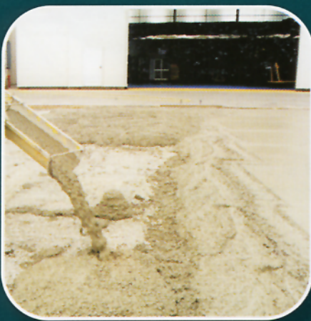
Pisos y pavimentos
