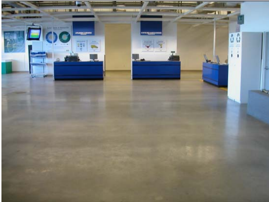
Piso sin juntas. Aumento considerable del espaciamiento entre juntas (15x15 m)(35kg/m 3 fibras de acero).
