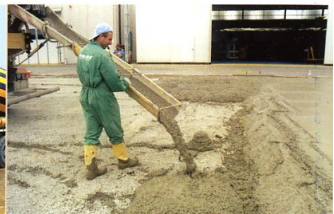
El hormigón reforzado con fibra puede ser vertido directamente desde camión o bombeado
