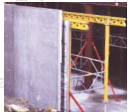
Muros de piezas prefabricadas con fibras de acero galvanizadas permiten la construcción de sótanos con reducidos plazos de ejecución.
