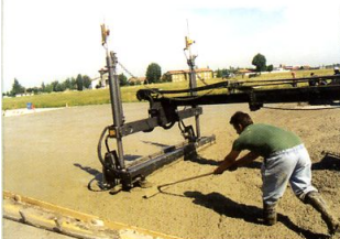
Regularización del hormigón por medio de equipamiento convencional o Laser Screed
