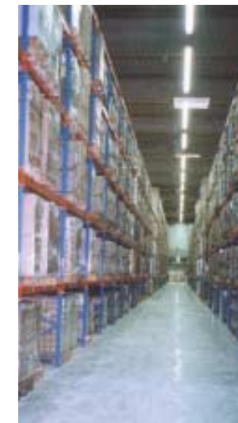
Los suelos industriales modernos de hormigón armado de fibra se caracterizan por su elevada capacidad portante, su alta resistencia a la fisuración y su durabilidad.
