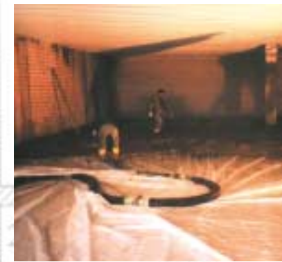
La mezcla e instalación de pavimentos de hormigón con fibras se realiza con tecnología y maquinaria convencional.
