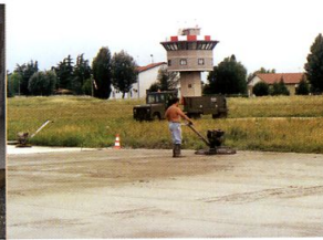
Acabado con helicóptero para posterior corte de juntas
